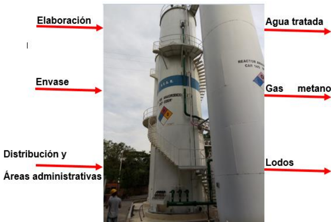
Figura 13. Proceso planta de tratamiento de aguas residuales.
