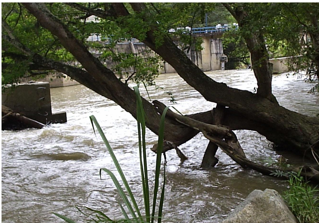
Foto 6: Aspecto físico del rio Suratá en la bocatoma de la planta Bosconia
