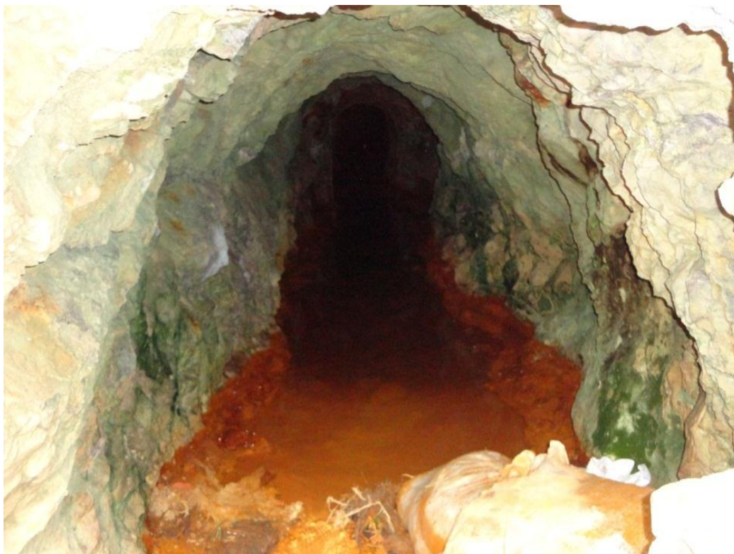
Foto 15: Primeros metros del socavón de la foto 14
