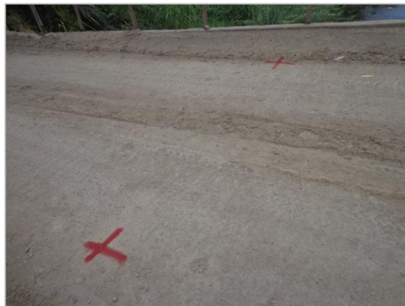
Figura 12. Demarcación de puntos de medida sobre la losa del puente.
