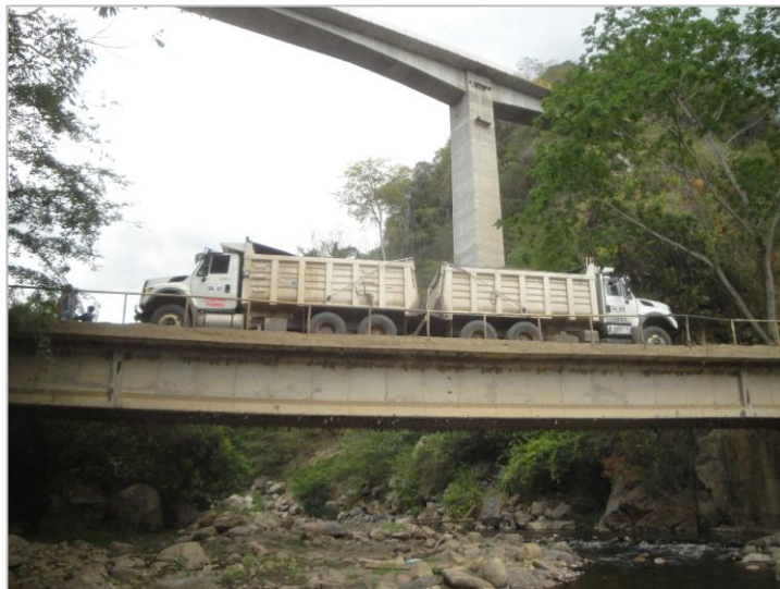
Figura 14. Prueba de carga – Fase #2
