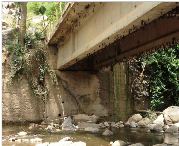
Figura 3. Puente El Ramo visto desde abajo
