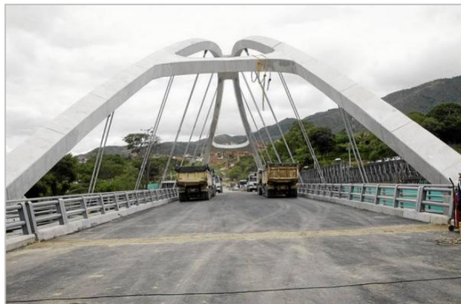
Figura 1. Prueba de carga al puente Flandes en Girón-Santander
