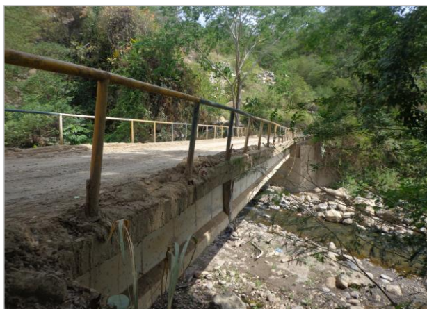
Figura 4. Vista longitudinal del puente El Ramo.
