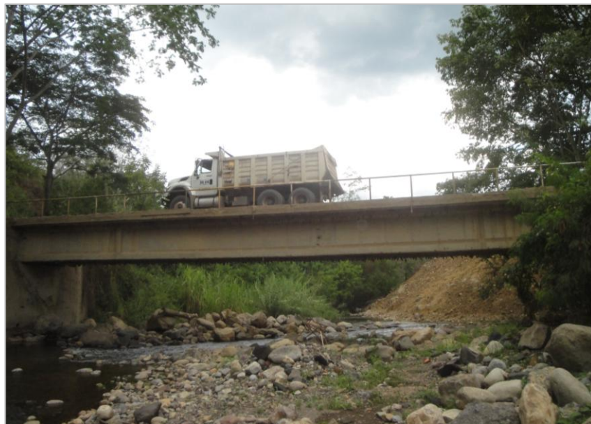
Figura 13. Fase 1 de la prueba de carga
