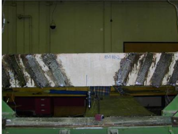
Figura 59. Falla de la viga reforzada con CFRP inclinado.
