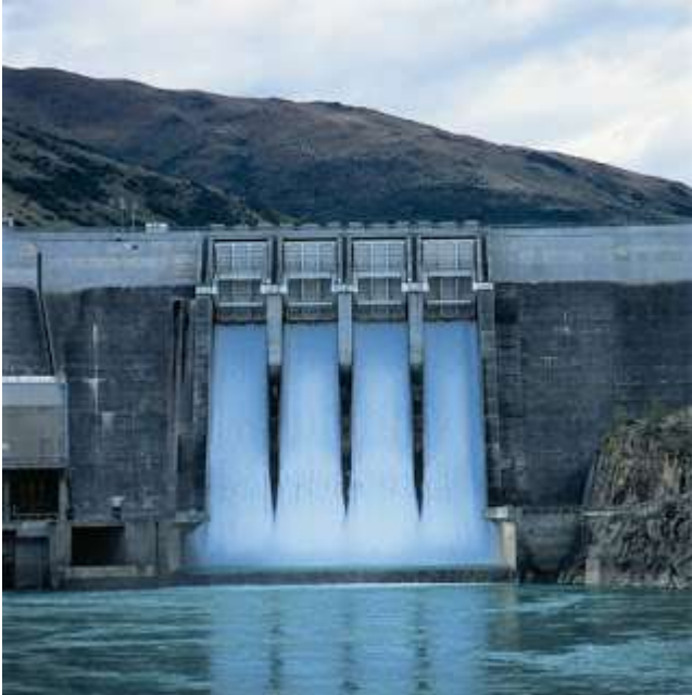
Figura 3. Represa para generar Energía Hidráulica
