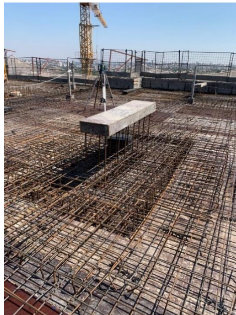
Figura 8. Armadura losa de entrepiso tipo maciza
