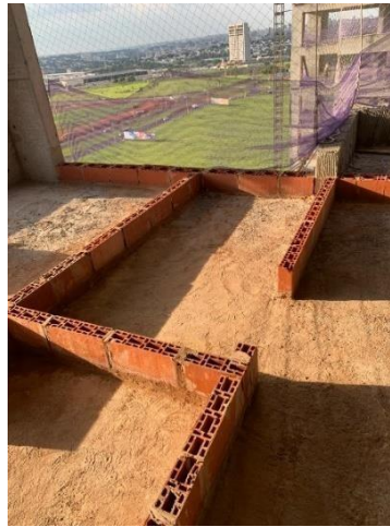
Figura 16. Primera hilada en apartamentos modelos
