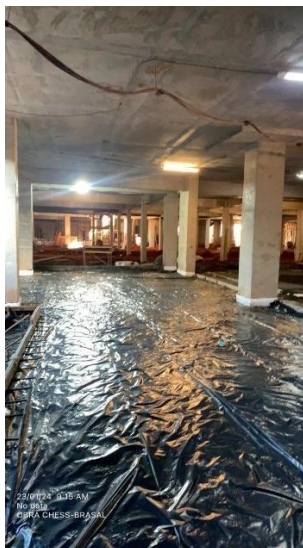
Figura 33. Protección contra la humedad con lona plástica
