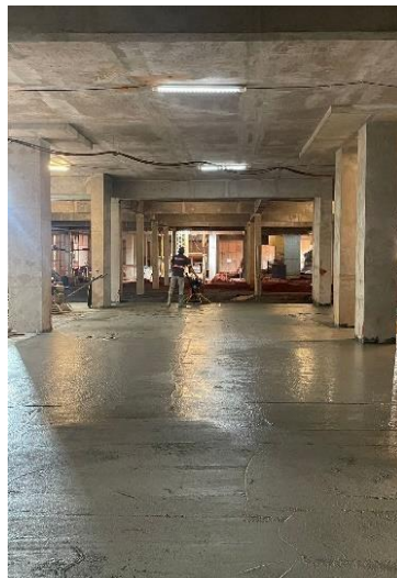
Figura 35. Ejecución del acabado cemento pulido.
