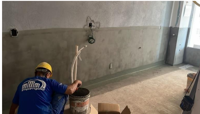
Figura 25. Aplicación de impermeabilizante en cocina
