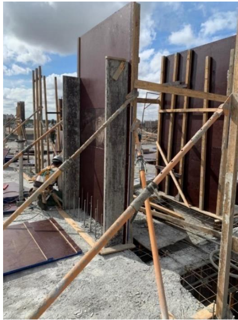
Figura 5. Proceso de instalación de formaletas para pilares
