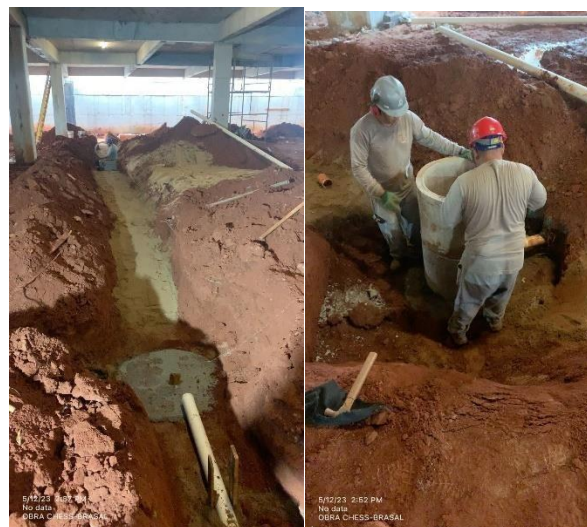
Figura 30. Instalación de redes hidrosanitarias en el subsuelo.
