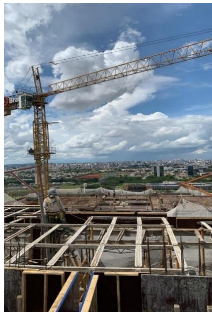
Figura 6. Proceso de instalación de formaletas para losa de entepiso.
