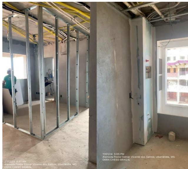
Figura 23 Montantes y placas para paredes de Drywall
