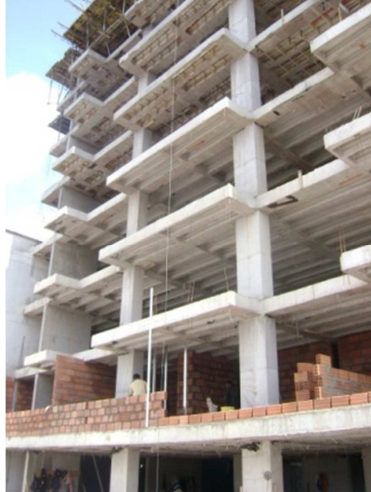
Figura 17. Mampostería de la obra
