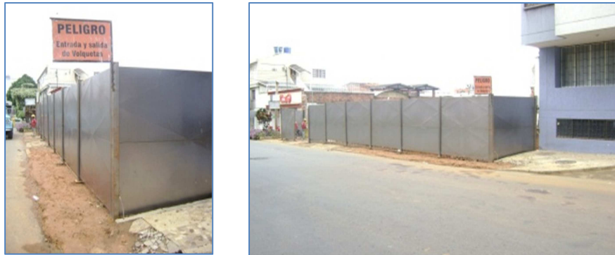
Figura 13. Encerramiento de la obra
