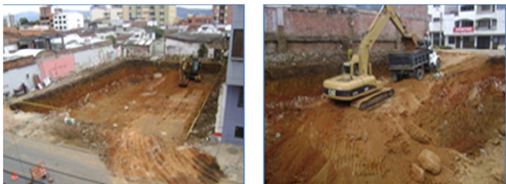
Figura 14. Excavación a máquina del área
