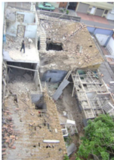
Figura 12. Proceso de demolición.
