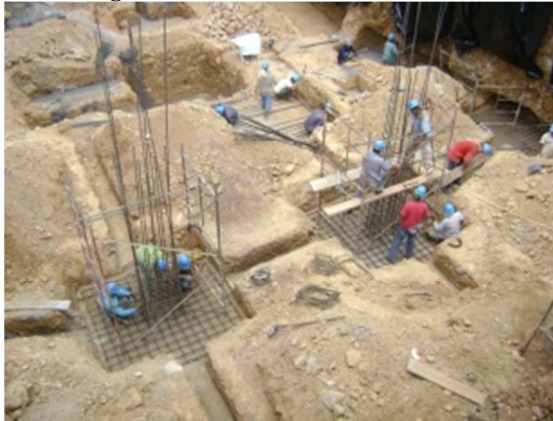
Figura 15. Cimentación de la obra
