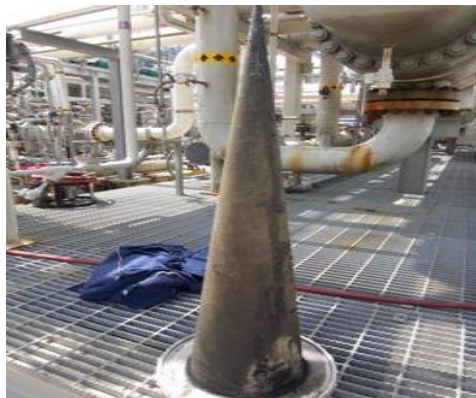
Figura 9. Registro fotográfico filtro de succión expuesto a temperatura ambiente, durante mantenimiento.
