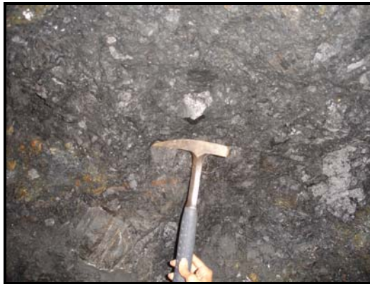
FIGURA 17: Aspecto de la zona III. Lodolita carbonosa con aspecto algo brechado.
