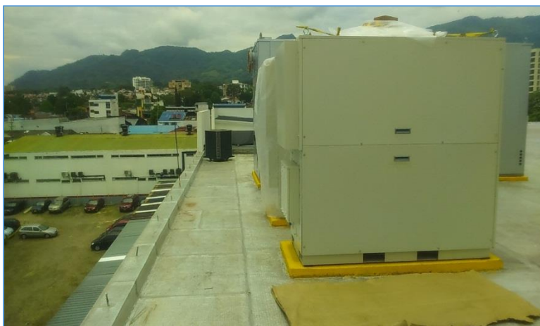
Figura 19. Microturbinas capstone, referencia C65.
