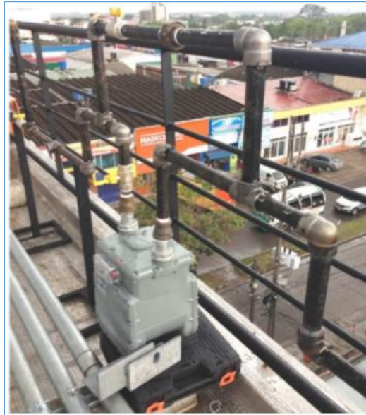
Figura 27. Instalación de gas microturbinas.
