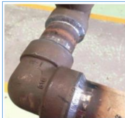
Figura 28. Cordón de soldadura con método de soldadura TIG (GTAW).
