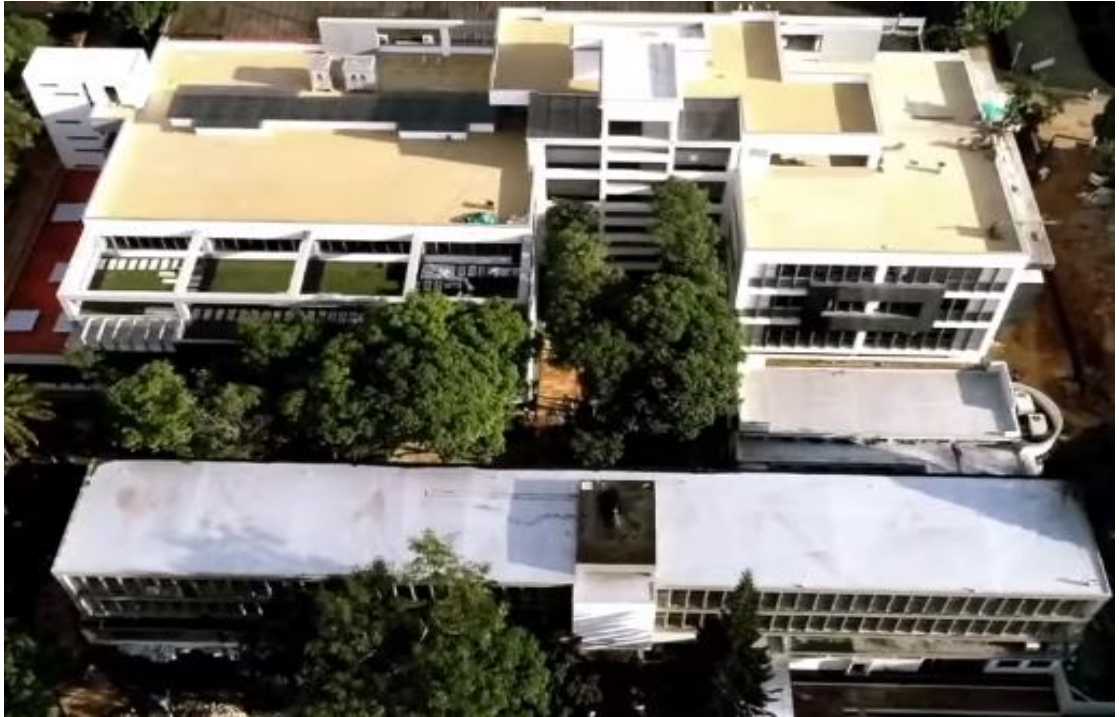
Figura 8. Vista superior edificio de laboratorios de Ingeniería Mecánica.
