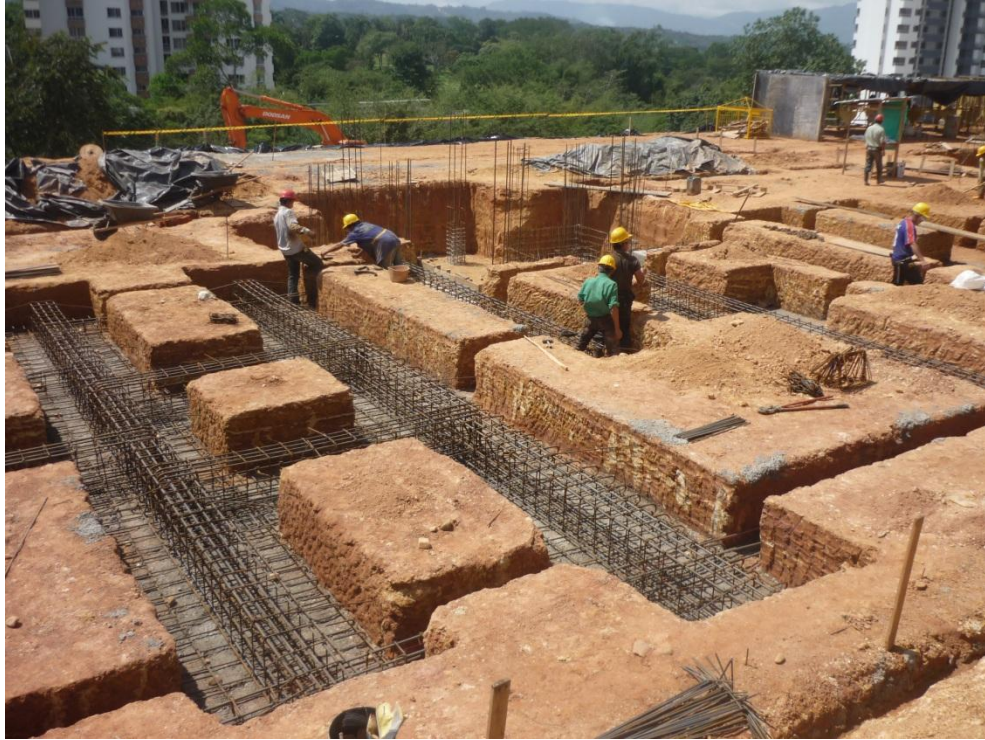
Figura 2. Cimentación Torres 3,4 y 5, Fuente: El autor
