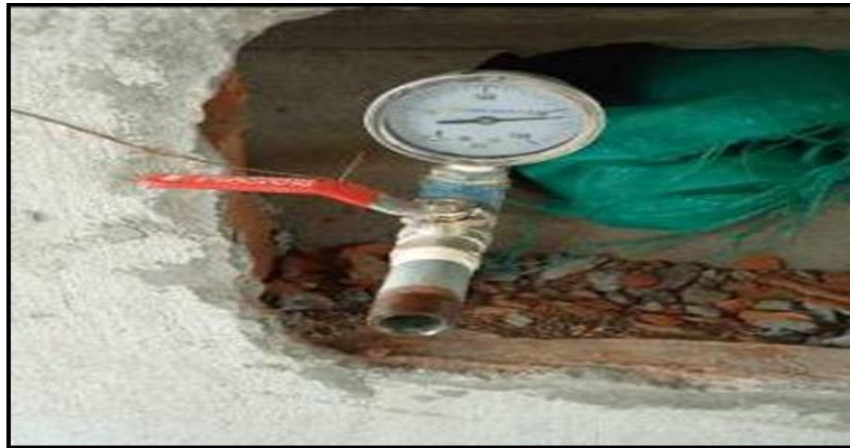
Figura 24. Prueba de Presión Hidráulica, Fuente: Registro Fotográfico, TAYRONA II
