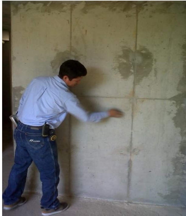
Figura 19, pulida Muro apto 702, Fuente: El autor
