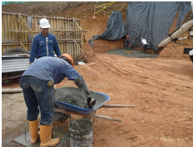
Figura 15. Inicio prueba de asentamiento, Fuente: El autor
