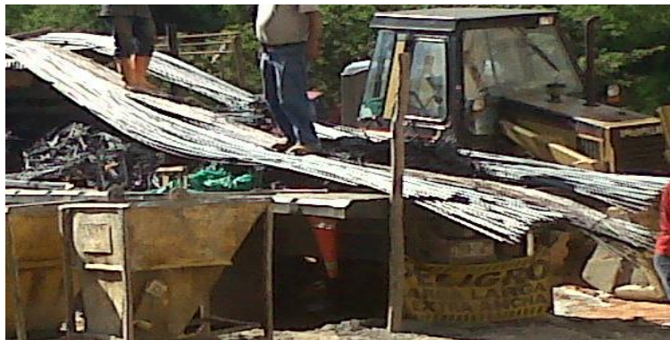
Figura 21, Aceros en obra, Fuente: El autor
