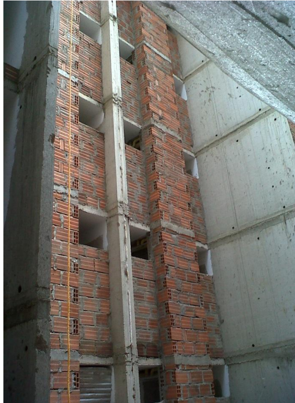
Figura 4. Mampostería Torre 2, Fuente: El autor
