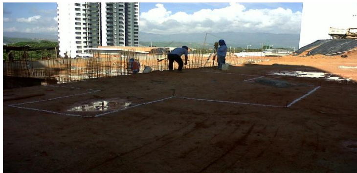
Figura 7. Demarcación de ejes parqueaderos, Fuente: El autor
