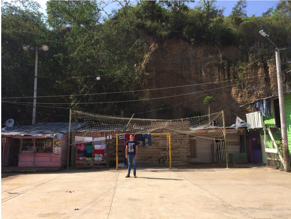
FIGURA 75. Viviendas aledañas a talud de mayor pendiente. Fuente: propia
