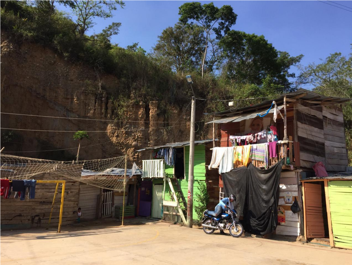
FIGURA 96. Viviendas sin requerimientos técnicos construidas al pie de la ladera
