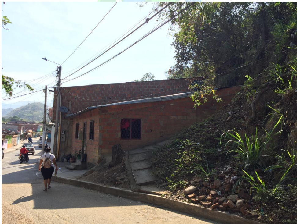
FIGURA 76. Viviendas aledañas a talud de mayor pendiente. Fuente: propia
