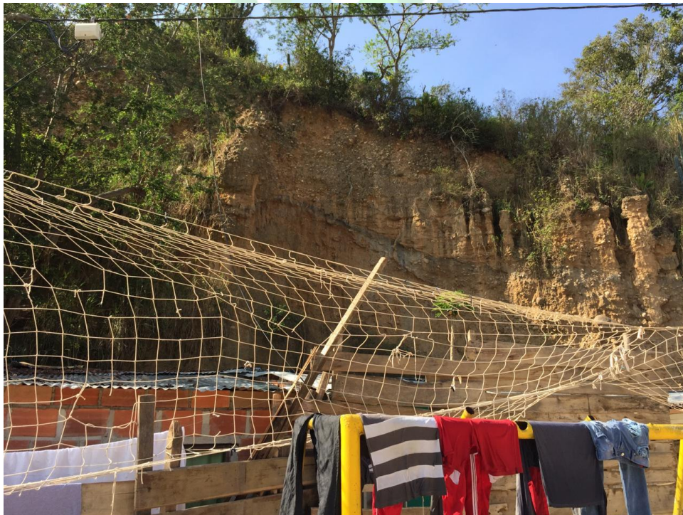
FIGURA 78. Talud con inclinación de 90° con viviendas aledañas al pie del mismo. Fuente: propia
