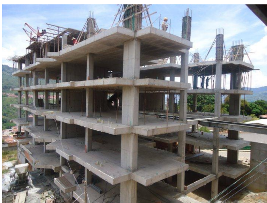
Inicio de obra
