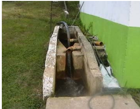
Figura 2.2. Canaleta Parshall de la planta del municipio de Lebrija
