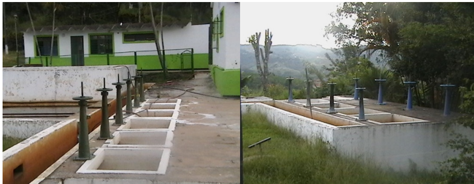
Figura 2.6. (a) y (b) Galería de filtros en la planta del municipio de Lebrija
