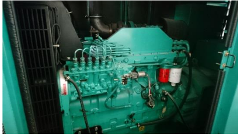
Figura 7 y 8: vista por ambos lados de motor generador Cummins
