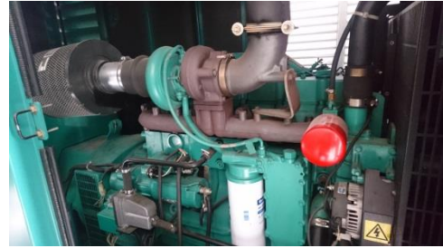
Figura 7 y 8: vista por ambos lados de motor generador Cummins
