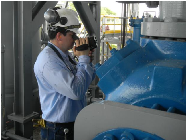
Figura 25. Termografía de válvulas de compresores reciprocantes
