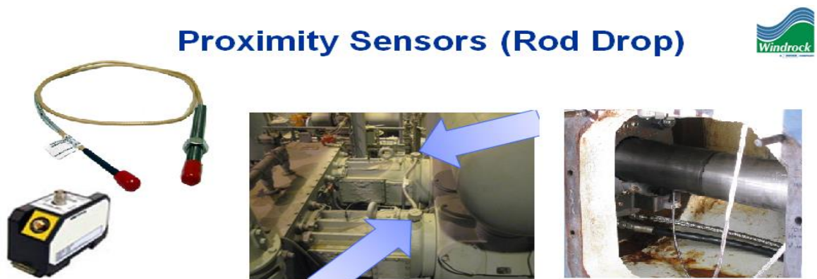
Figura 51. Instalación de Sensores de Proximidad en cilindros de compresores recíprocos.
