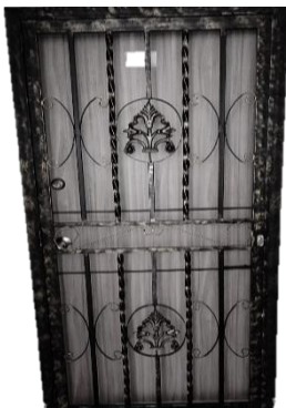
Reja para acceso principal
