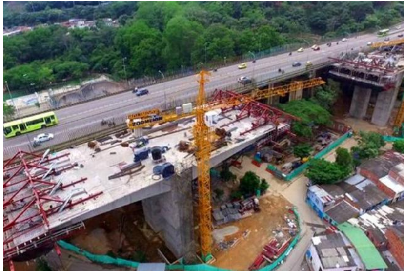
Figura 6. Construcción de dovelas
