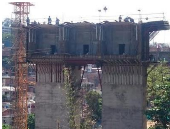
Figura 5. Construcción de la pilotes.
