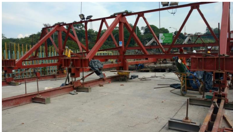
Figura 13. Carro de Avance Tramo Sur
