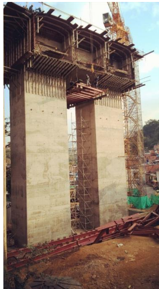
Figura 9. Construcción de dovela cero
