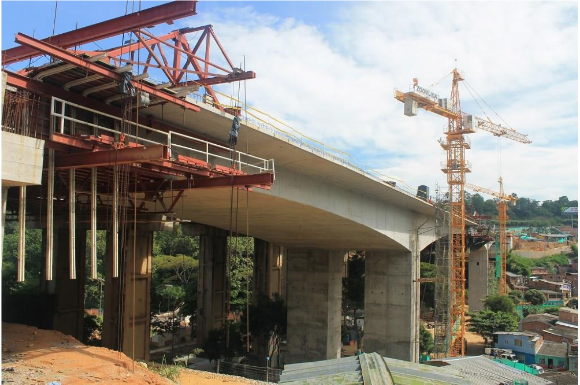
Figura 7. Construcción de dovelas en los estribos. Cierre del puente
