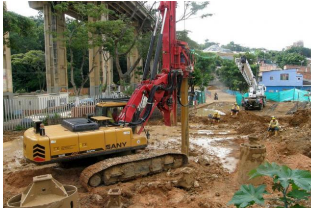
Figura 4. Construcción de la pilotes.
