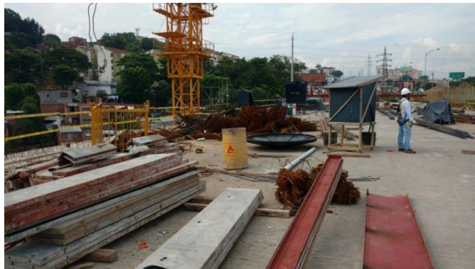
Figura 27. Registro fotográfico de material sobre el tablero del Tramo Sur
