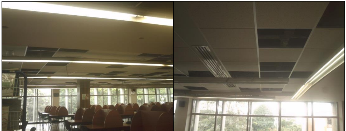
Figura 7. Mantenimiento a las instalaciones de Biblioteca
