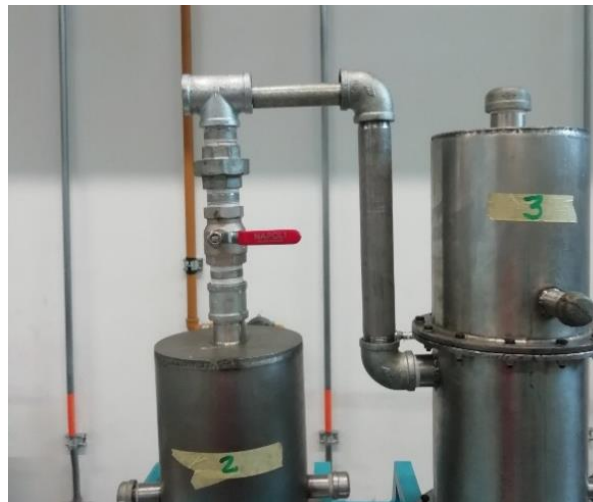
Figura 17. Inicio de la conexión entre equipos Evaporador- Condensador.
