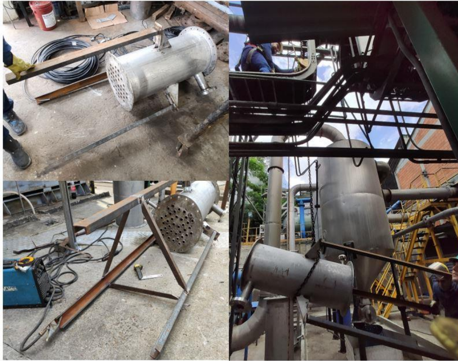
Figura 33. Instalación de soportes.
