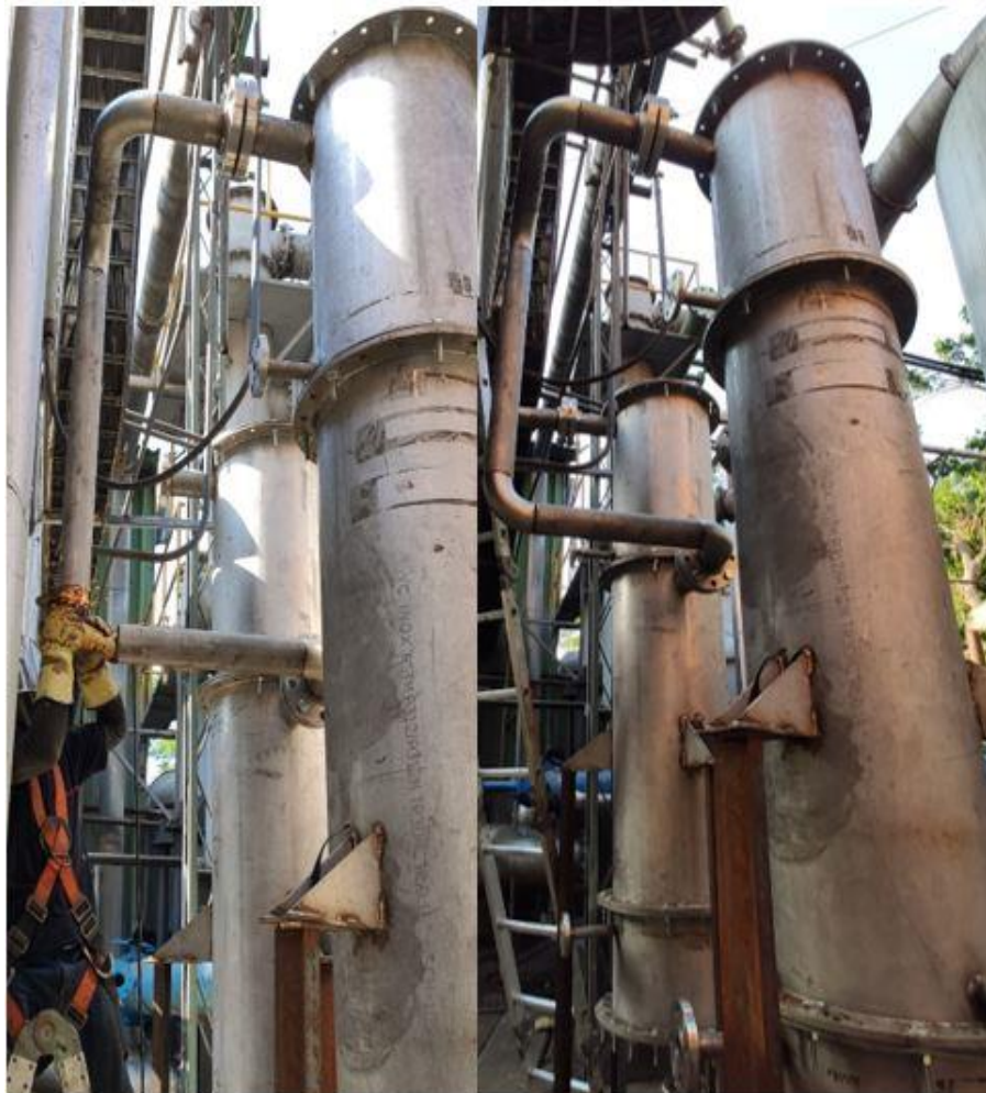
Figura 39. Conexión primer y segundo Evaporador.
