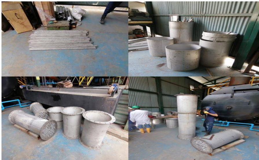
Figura 30. Corte y ensamblaje de Evaporadores y Condensador.
