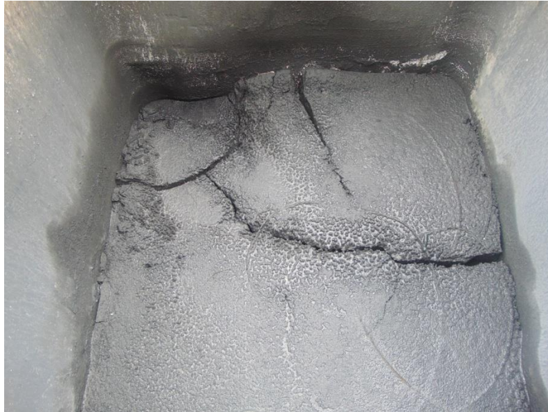
Figura 6. Material particulado sedimentado captado en lavador (Scrubber) vía húmeda
