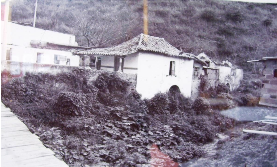
Figura 17: Foto de una casa del barrio Los Molinos
