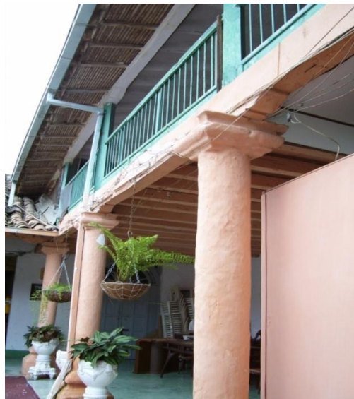
Figura 7: Foto de la construcción de una vivienda “alta” en tapia y calicanto con balcón.
