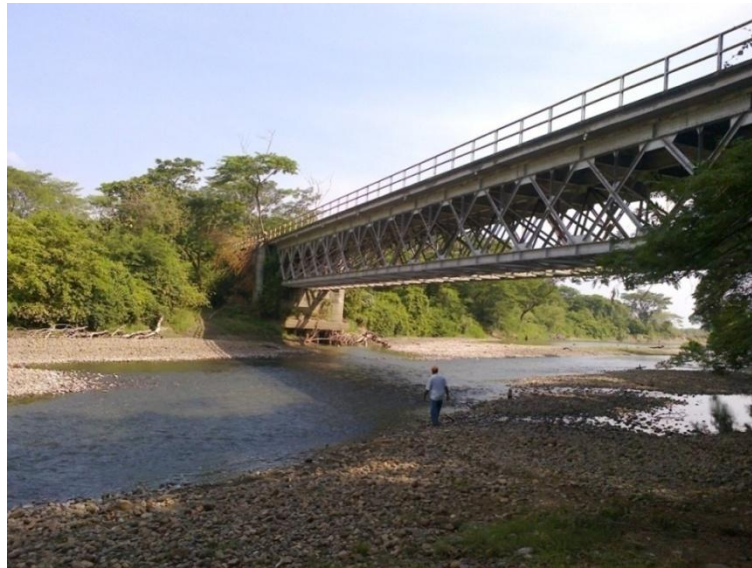
Figura 28. Puente vehicular, al inicio del tramo de estudio en el presente documento
