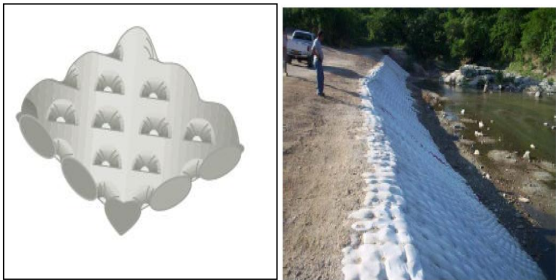
Figura 84 Izquierda. Esquema de la tela sintética. Derecha. Formaleta flexible llena de concreto fluido instalada en la margen de una corriente superficial
