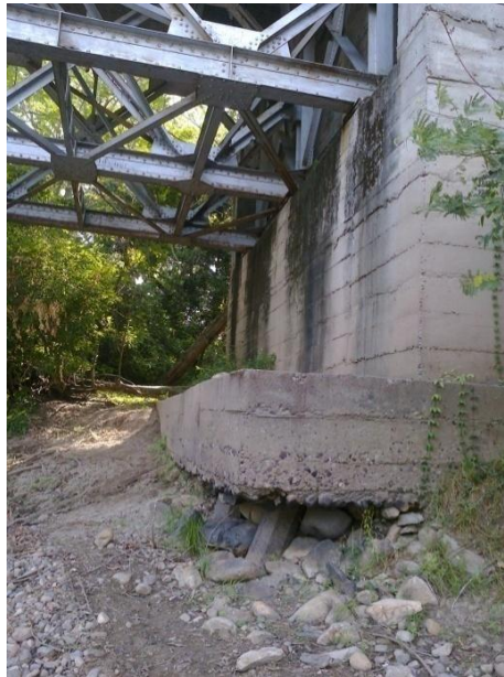
Figura 29. Aspecto del estribo izquierdo del puente ubicado en el sector Las Garzas, sobre el río Cesar
