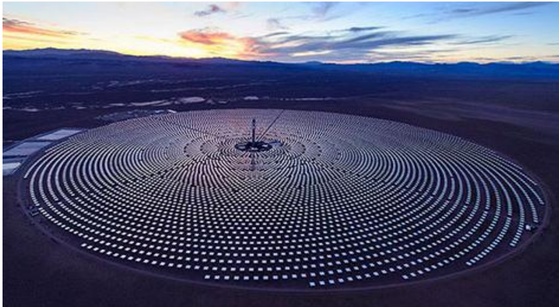
Figura 20. Vista aérea de la planta de generación de energía termosolar de nevada
