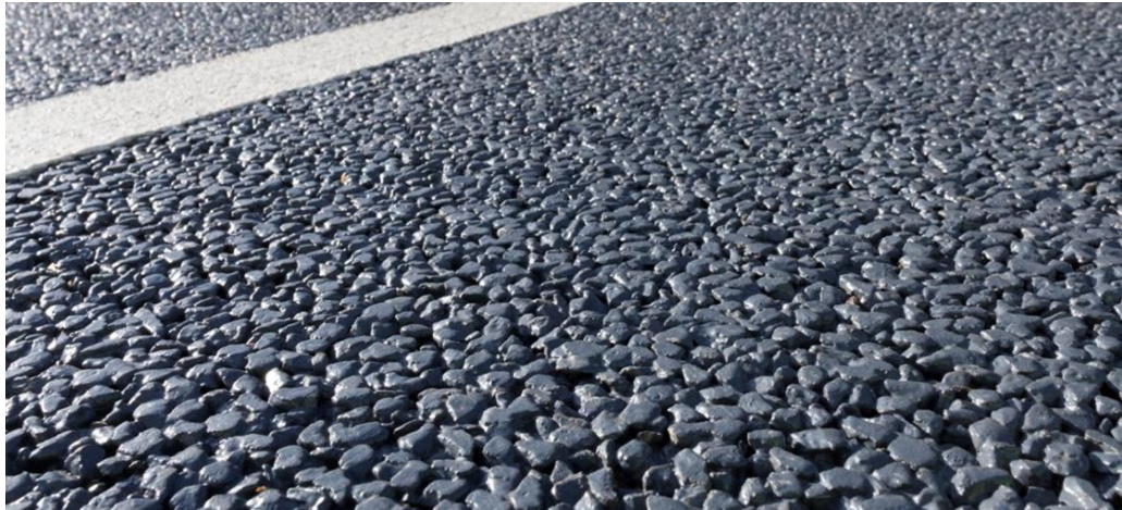
Figura 33. Aspecto de una superficie pavimentada con concreto permeable
