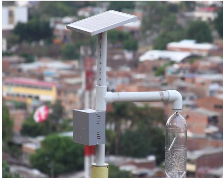
Figura 23. Estructura del sistema “Un litro de luz”
