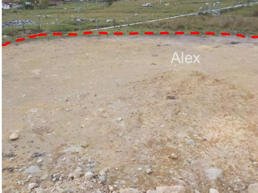
Fotografía 22. Vista al NW, se aprecia explanación, para posible construcción de algún tipo de estructura.
