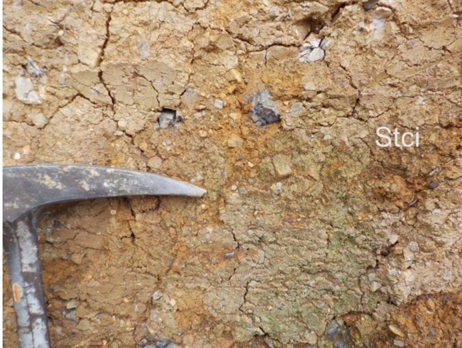
Fotografía 28. Vista de Trinchera al NE, en donde se aprecia Suelo Transportado Coluvial Inactivo (Stci).
