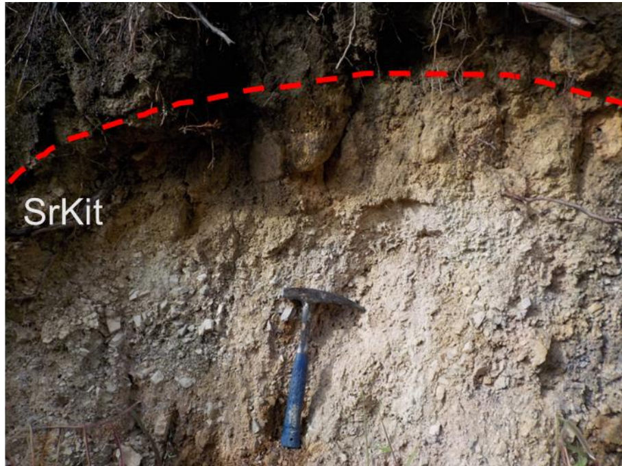
Fotografía 26. Vista de Trinchera al NE, Suelo Residual de la Formación Tablazo.
