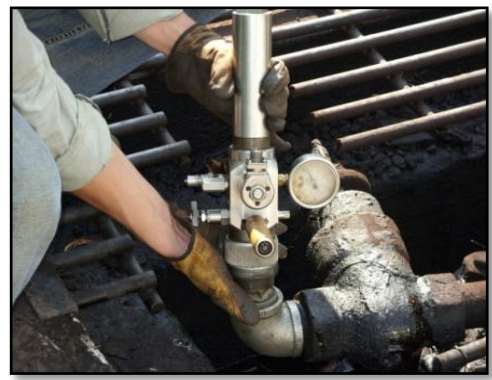
Figura 37 B: Instalación la de Pistola en Anular de pozo.
