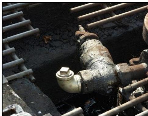
Figura 37 A: Válvula Anular cerrada
