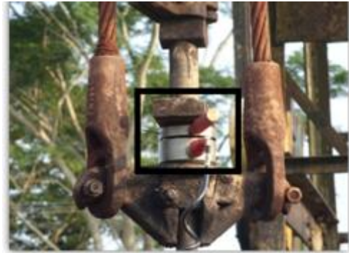
Figura 7 B. Instalación en la barra porta varillas
