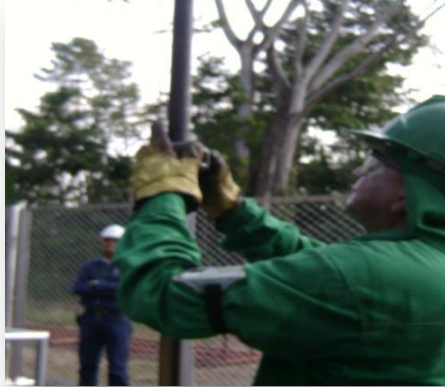
Figura 70 A: Colocar Grapa o abrazadera en la barra lisa.
