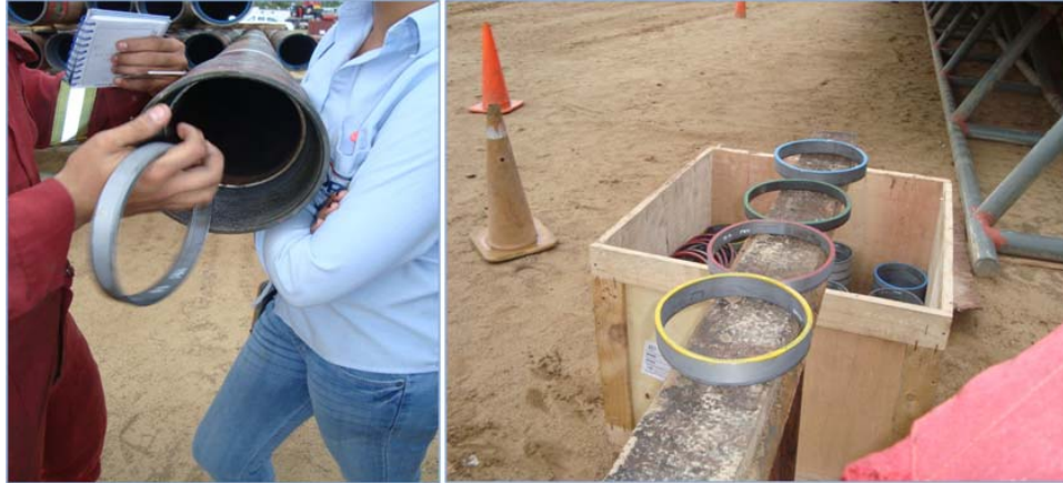
Figura 70. Instalación de Anillos MLT.
