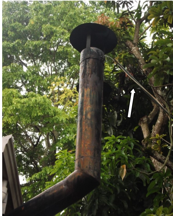
Figura 36. Instalación para la toma de las muestras.
