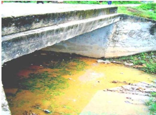
➤ **Evaluación técnica del sistema.** La evaluación técnica del sistema arrojó como resultado que el canal tiene la capacidad de desviar, transportar y evacuar las aguas lluvias hasta la fuente superficial a la cual realiza el vertimiento sin ningún inconveniente.
