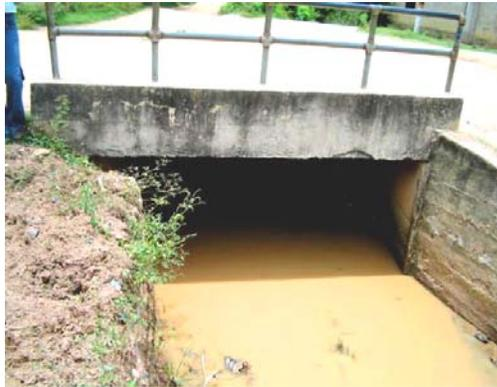
**Fotografía 14. Cambio de sección del canal**
