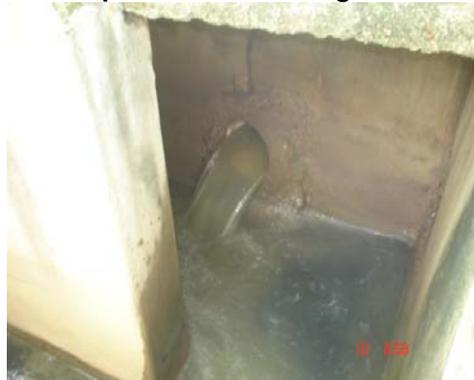
Esta estructura recibe las aguas residuales crudas provenientes del alcantarillado municipal y está diseñado para retener la arena y otros residuos minerales inertes. Tiene dimensiones de 1.8 m de ancho por 1.75 m de largo con el propósito de que el material sólido suspendido sedimentable se deposite en el fondo del tanque (fotografía 69).
