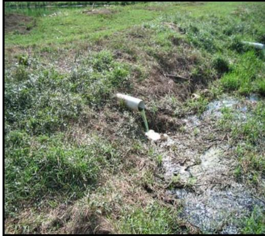
**Fotografía 23. Tubería de entrada a las laguna, además proliferación de vegetación en la laguna No 1 del sistema norte.**
