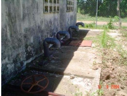
○ **Pozo Seco.** El proceso de bombeo se realiza por medio de tres bombas centrifugas de igual capacidad las cuales trabajan en paralelo (tabla 44), las cuales están ubicadas en el pozo seco, estas se encargan de extraer las aguas negras del pozo húmedo e impulsarlas hasta una tubería de 12 pulgadas de asbesto cemento, la cual las conduce hasta el sistema de tratamiento de aguas residuales.
