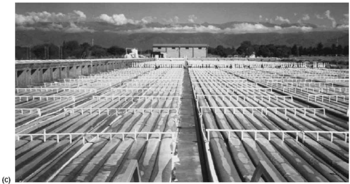
Figura D1. Fotobiorreactores a escala comercial. (a) Fotoiorreactor Ltd en Santa Ana, Murcia, España. (b) una particularidad del sistema vertical de Fotobiorreactores en Julio 1995, cuatro años después del cierre. (c) La Planta Hidrológica SA construida en La Rioja, Argentina (fuente Tredici 1999)
