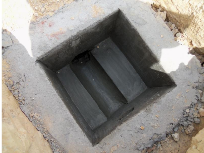
Fotografía 1. Caja de inspección.
