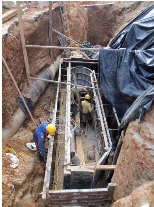
Fotografía 6. Estructura de separación.
