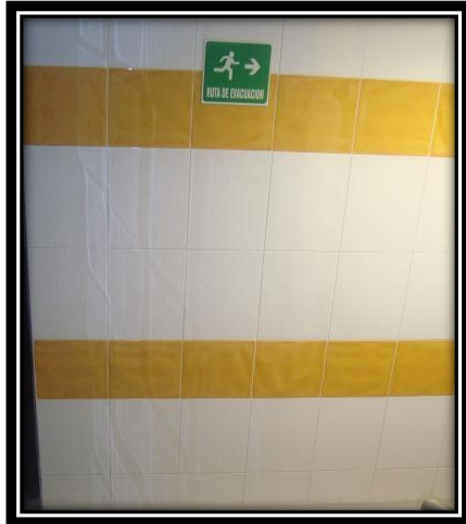
Entrada Interna Zona de Pique
