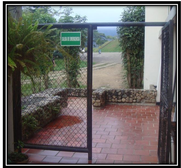
Puerta acceso comedores
