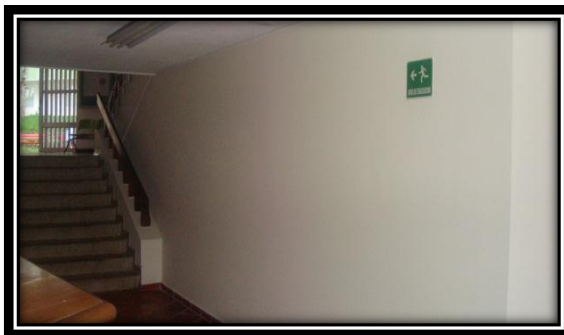
Pasillo entrada principal del edificio BU - Comedores
