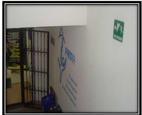
Gradas entre tercer piso y Psicorientación.
