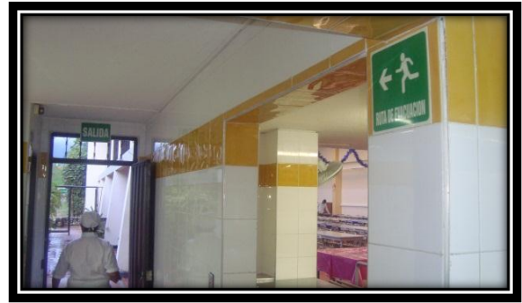
Pasillo cocina comedores-salida dirección oriente
