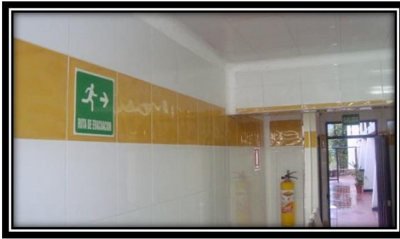
Pasillo cocina comedores salida dirección oriente
