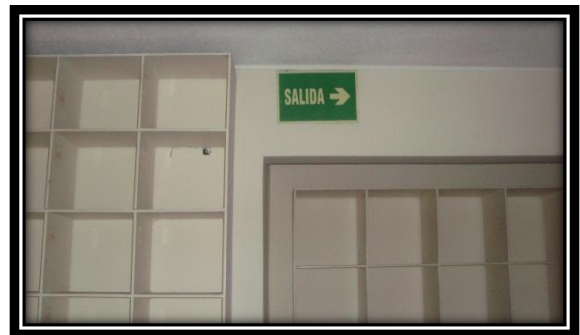
Pasillo entrada principal del edificio BU - Comedores
