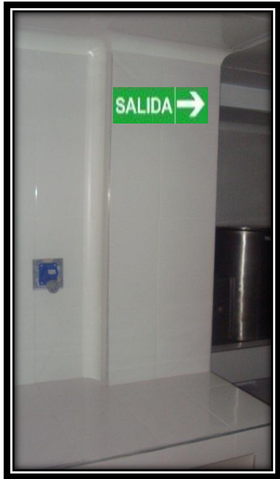
Señal derecha zona del pique
