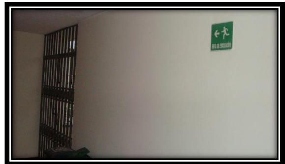
Pasillo entrada principal del edificio BU - Comedores
