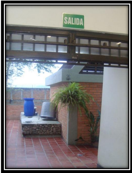
Puerta salón de comedores hacia los baños.
