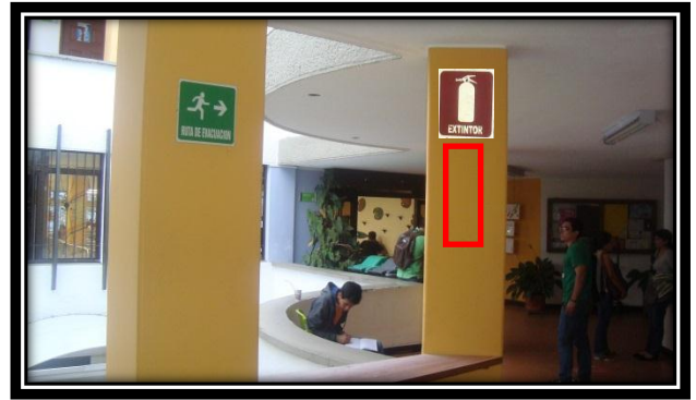
Pasillo Jefatura Sección Comedores y Cafetería
