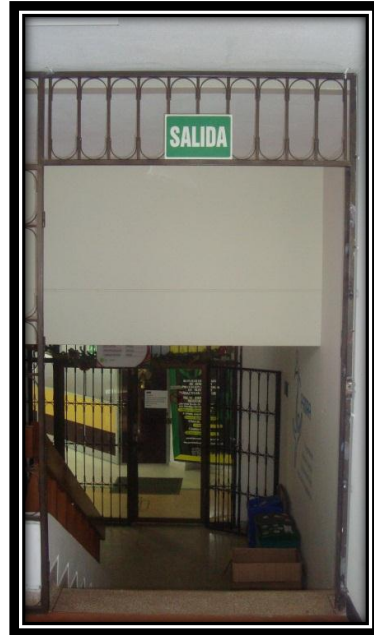
Puerta principal tercer piso
