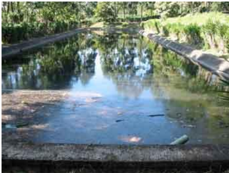
Figura 18. Laguna anaerobia
