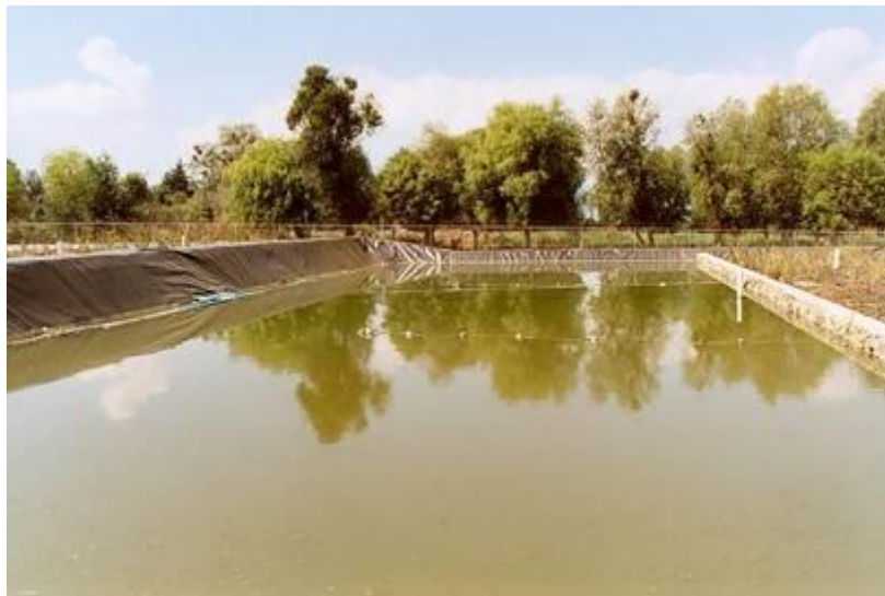
Figura 22. Laguna de maduración
