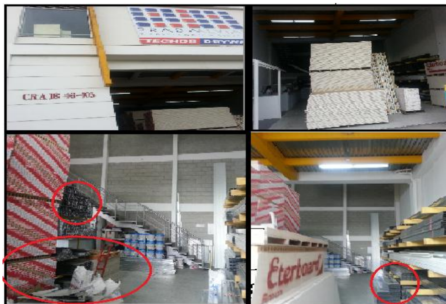
Imagen 7. Inspección de Prada Alviar Ltda.
