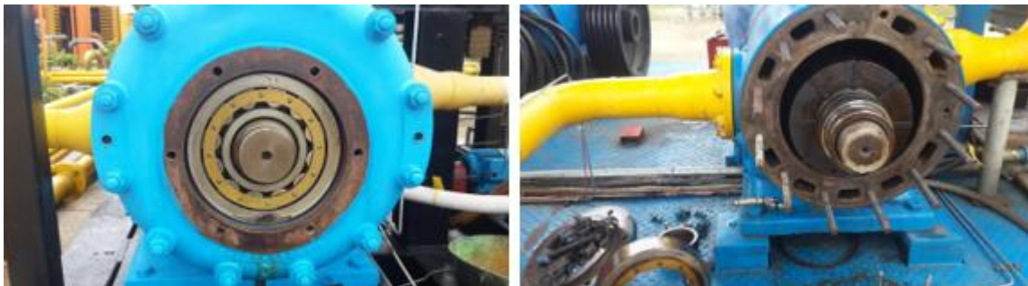
Figura 21. Reparaciones al compresor.
