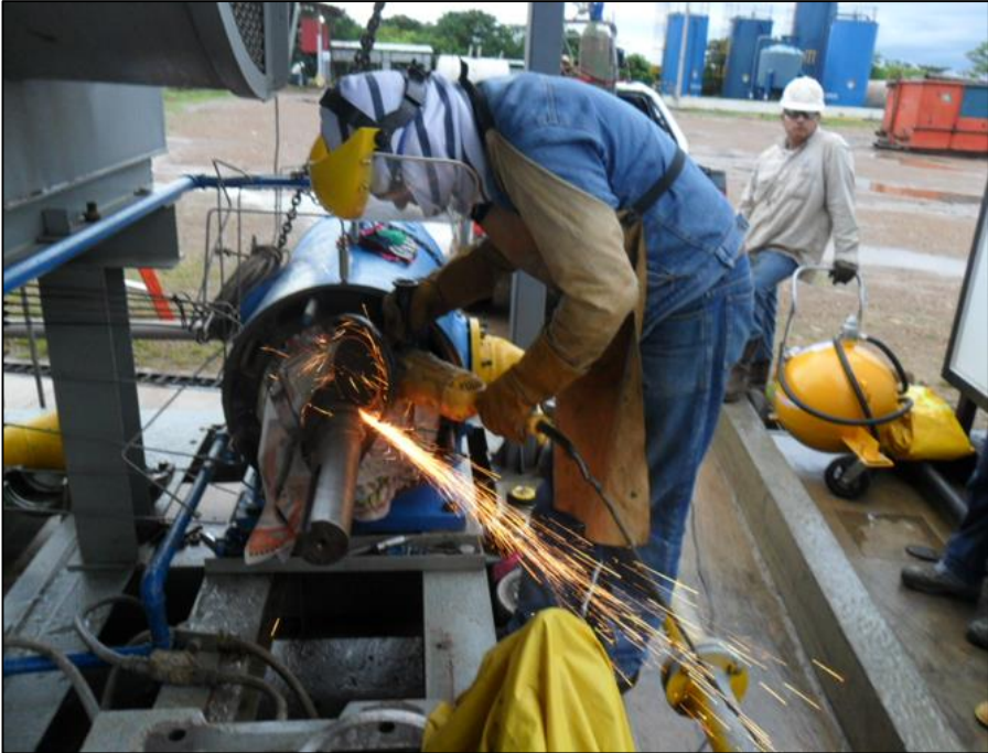
Anexo H. Aplicación de oxicorte para retiro de base de rodamiento del compresor.
