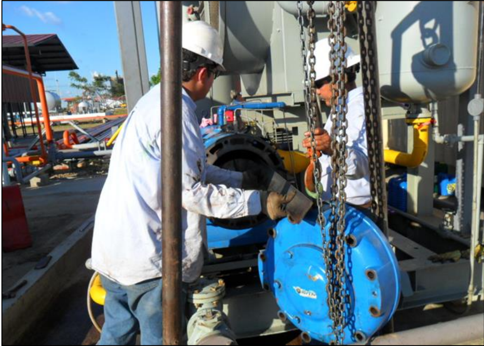
Anexo E. Falla de aspas del compresor.
