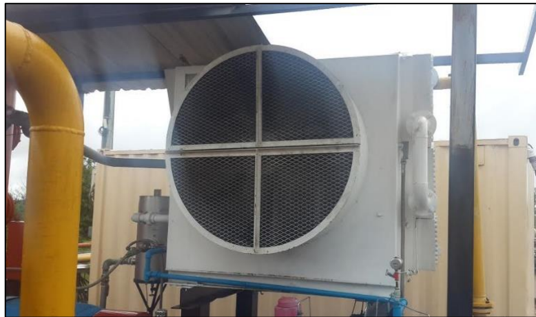
Figura 17. Aero-enfriador de tiro forzado.
