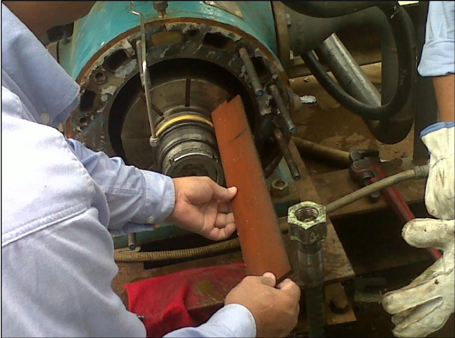
Anexo D. Rompimiento de aspas del compresor.
