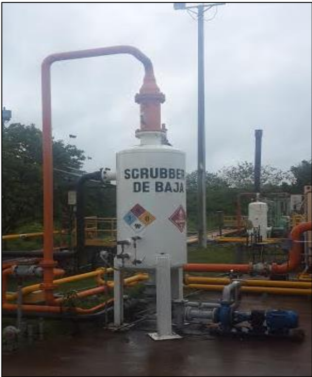
Figura 16. Banco de bombas y condensado de agua.
