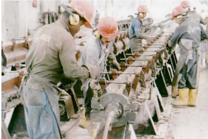
Figura 1.1. Fabricación de postes de concreto preesforzado (Pretecor Ltda)
