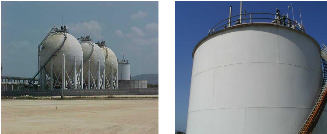
Figura 4. Tanques de Almacenamiento
