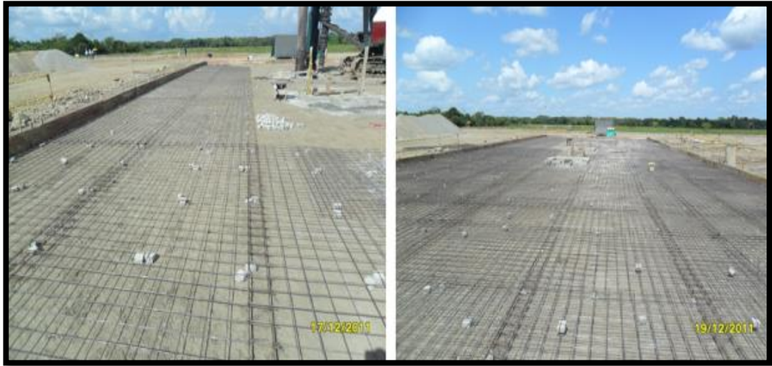
Figura 11. Instalación de malla electrosoldada
