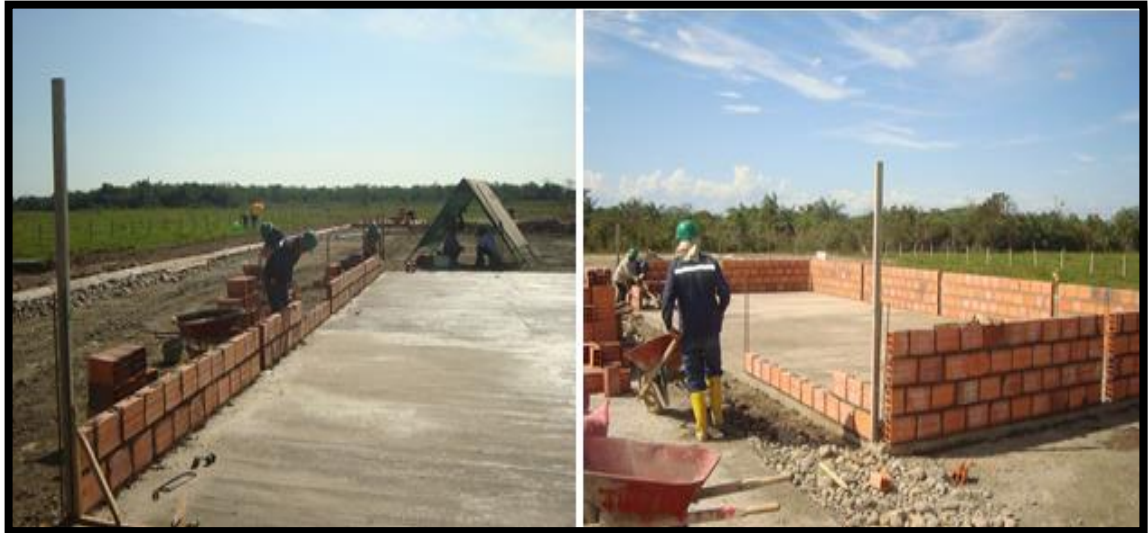
Figura 14. Instalación de ladrillos para construcción del dique
