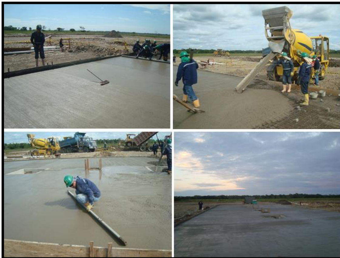
Figura 13. Fundida de la losa con respectivo acabado
