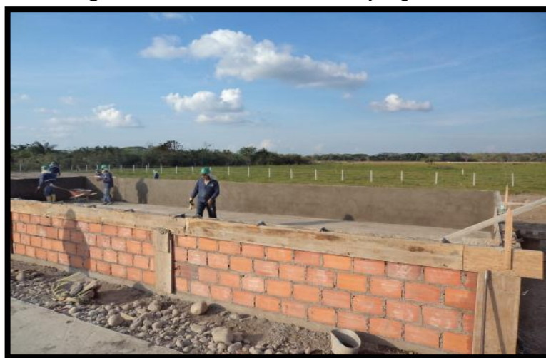
Figura 15. Vaciado columnetas y viga amarre
