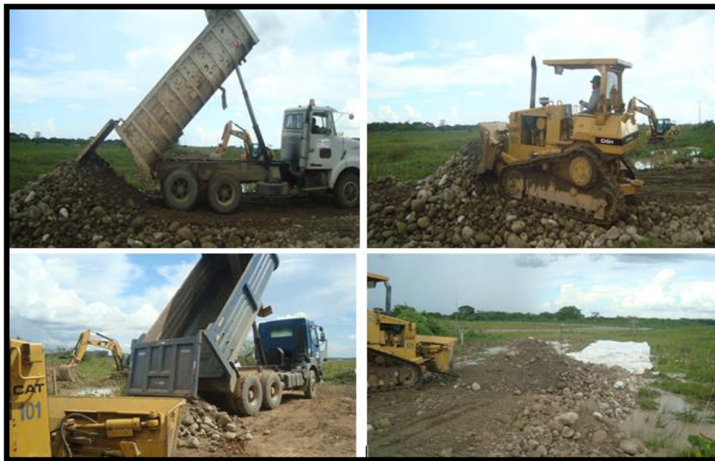
Figura 5. Colocación y extendido de material de crudo de río
