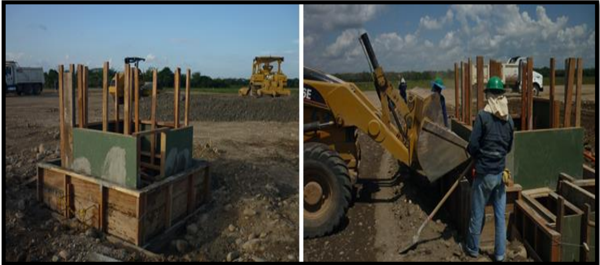
Figura 9. Encofrado y vaciado contrapozo (Cellar)
