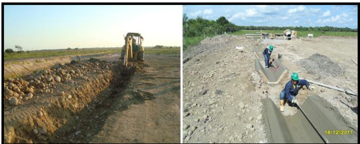
Figura 17. Excavación y vaciado del concreto
