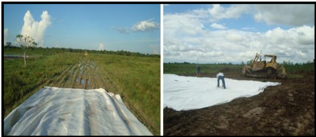
Figura 4. Instalación geotextil
