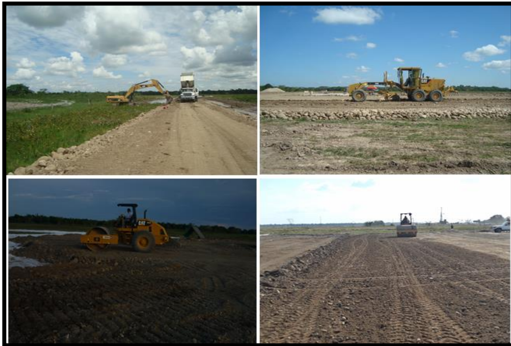
Figura 6. Conformación y compactación de la capa de afirmado
