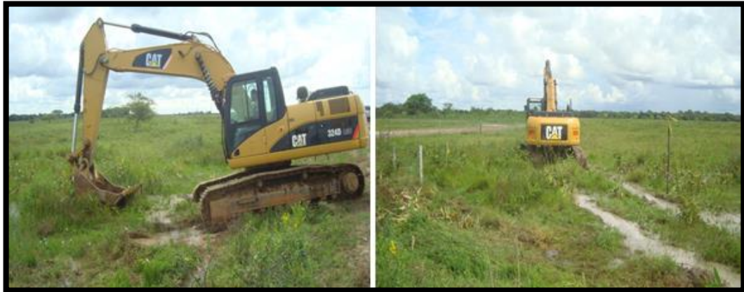
Figura 3. Descapote zona vía de acceso
