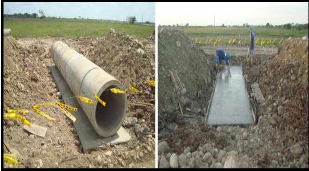
Figura 7. Losa de fondo e instalación de tubería 36''
