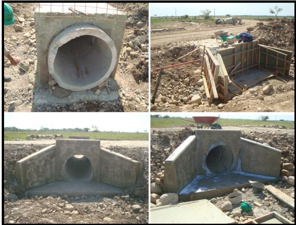
Figura 8. Atraque de tubería y detalle del cabezote
