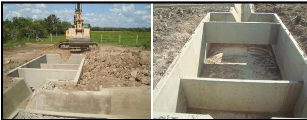
Figura 18. Construcción skimmer típico
