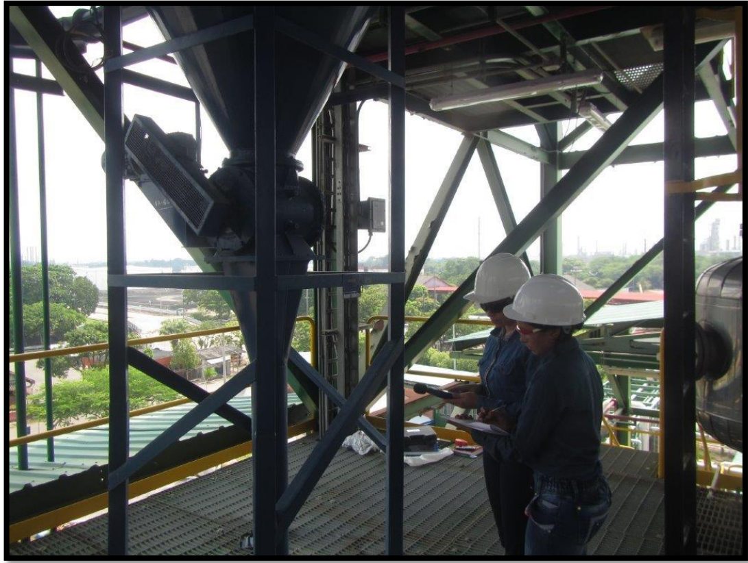
Fotografía que muestra una toma de medición de ruido en el equipo FRT de la planta Ecodiesel.
