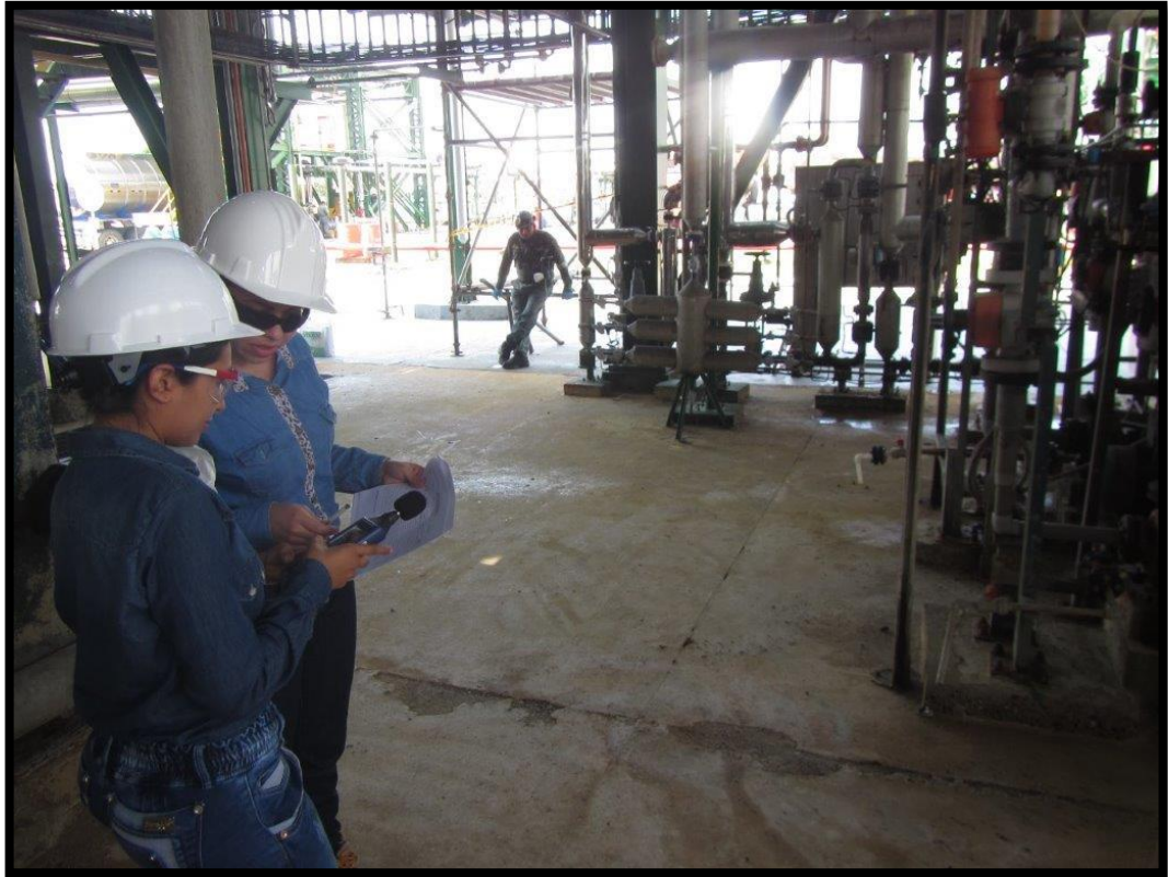
Fotografía que muestra una toma de medición de ruido en la entrada de la planta Ecodiesel.
