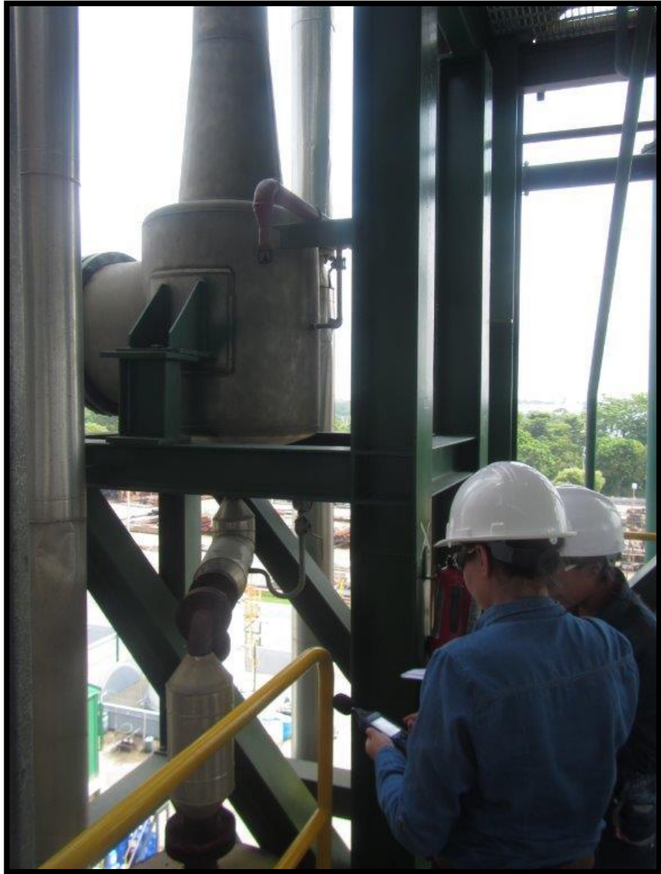
Fotografía que muestra una toma de medición de ruido en el lado derecho del equipo M613630A62 de la planta Ecodiesel.
