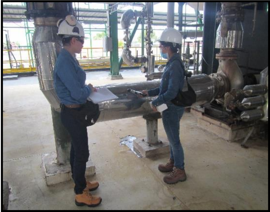
Fotografía que muestra una toma de medición de estrés térmico en el intercambiador de ácido graso 881A6 de la planta Ecodiesel.
