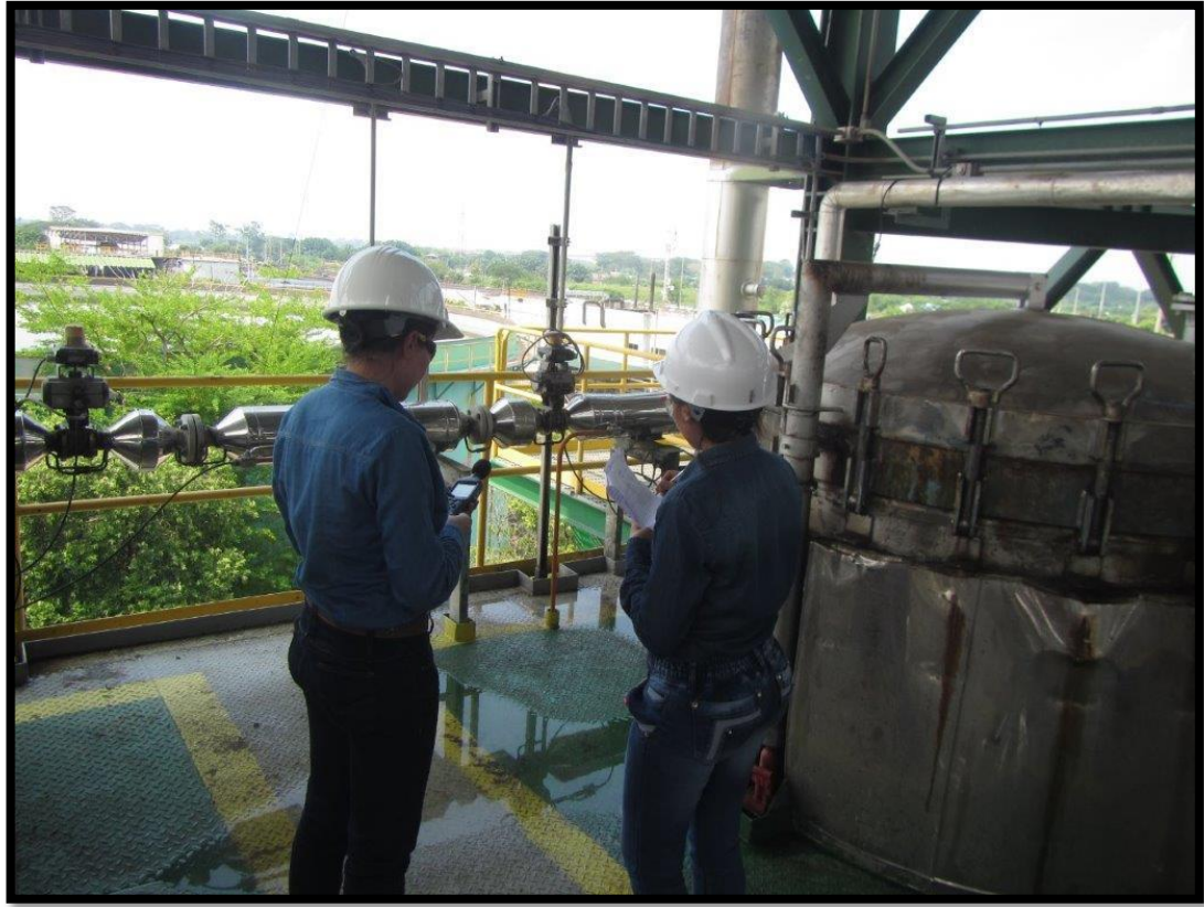
Fotografía que muestra una toma de medición de ruido en el en la válvulas y filtros de la planta Ecodiesel.
