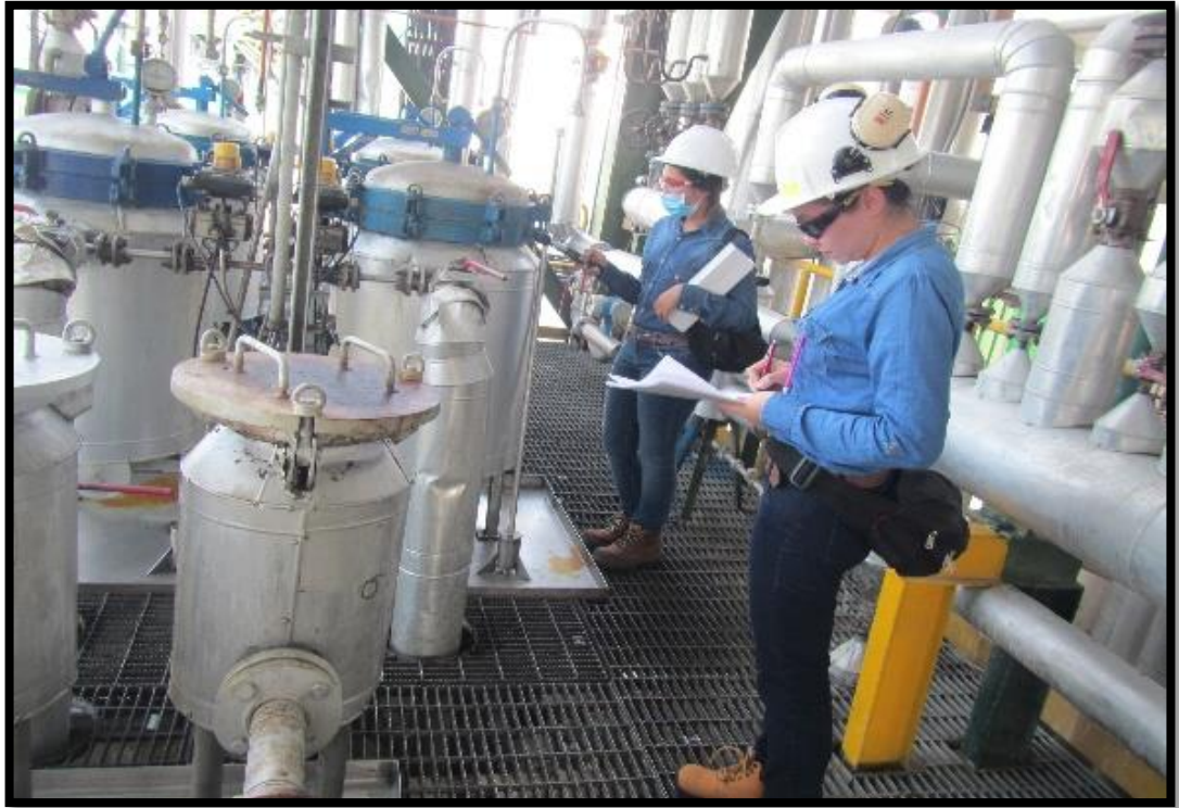
Fotografía que muestra una toma de medición de estrés térmico en el filtro 616B2 de la planta Ecodiesel.
