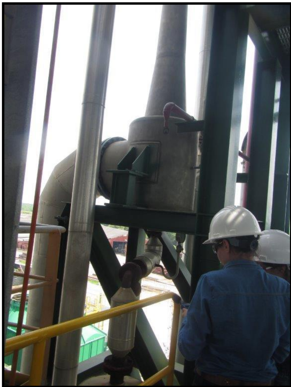
Fotografía que muestra una toma de medición de ruido en el lado derecho del equipo 68213 de la planta Ecodiesel.
