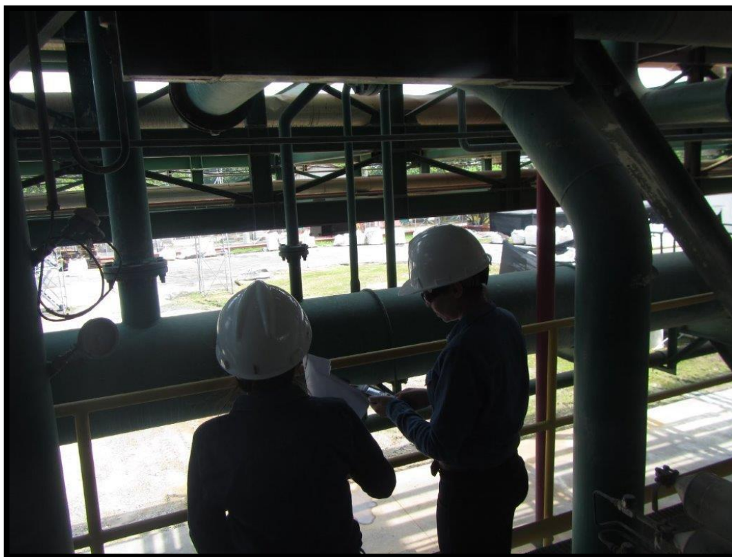
Fotografía que muestra una toma de medición de ruido en el intercambiador de calor 8-81 de la planta Ecodiesel.
