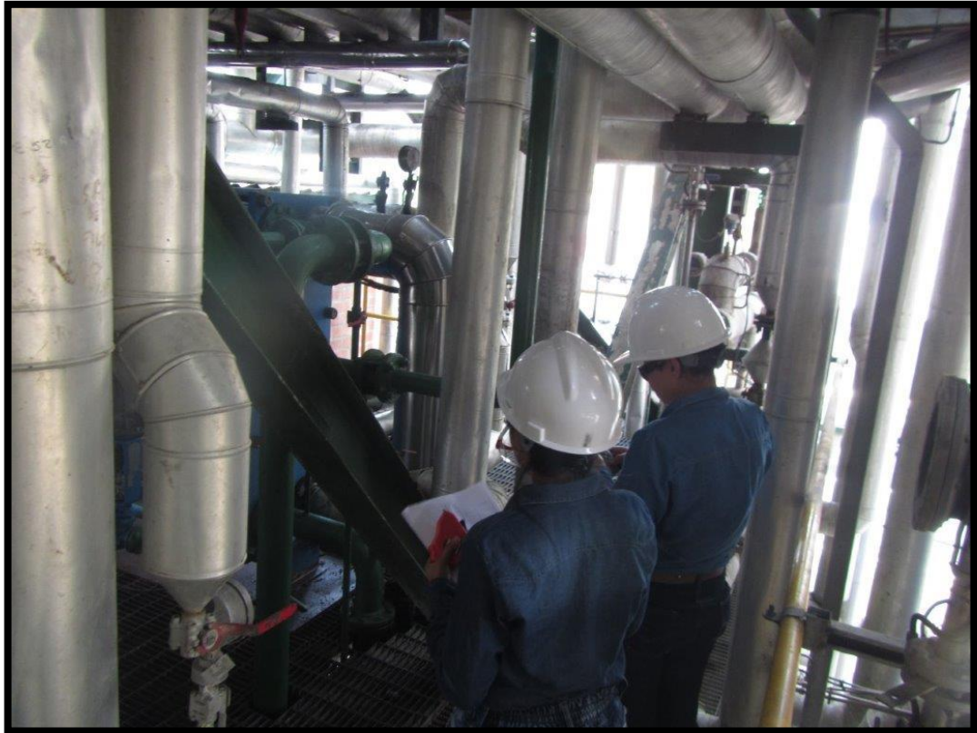
Fotografía que muestra una toma de medición de ruido en las válvulas y filtros de la planta Ecodiesel.
