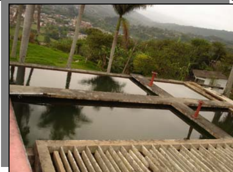
Figura A10. Sedimentadores
