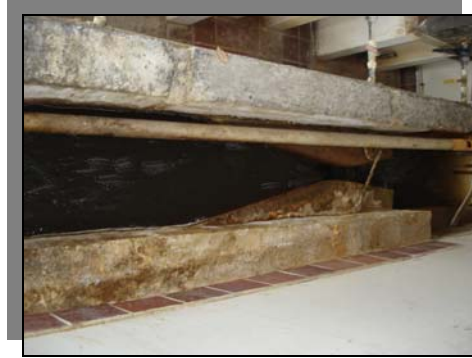
Figura A8. Canaleta Parshall
