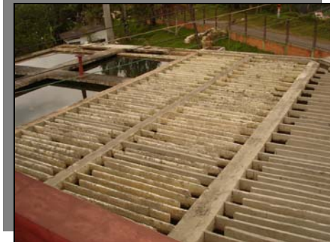
Figura A9. Floculadores hidráulicos
