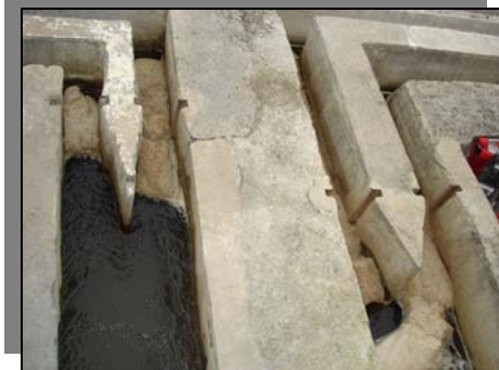
Figura A9. Floculadores hidráulicos
