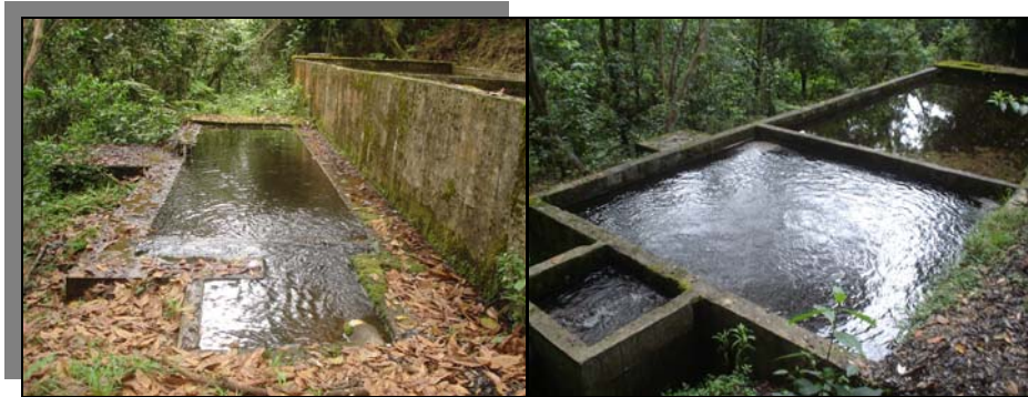
Figura A3. Desarenadores
