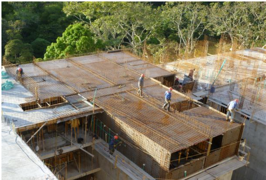
Figura 9. Colocación de malla en placa.
