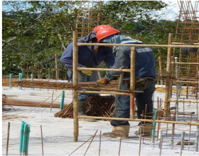
Figura 8. Armado de vigas.
