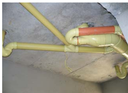
Techo sin dry wall
