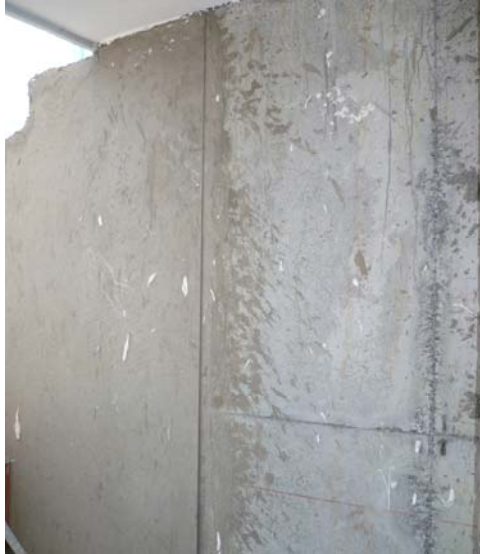
Ilustración 10 Junta entre mampostería y muro estructural
