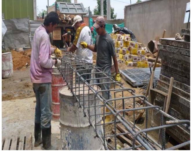
Armado del refuerzo, viga cemento
