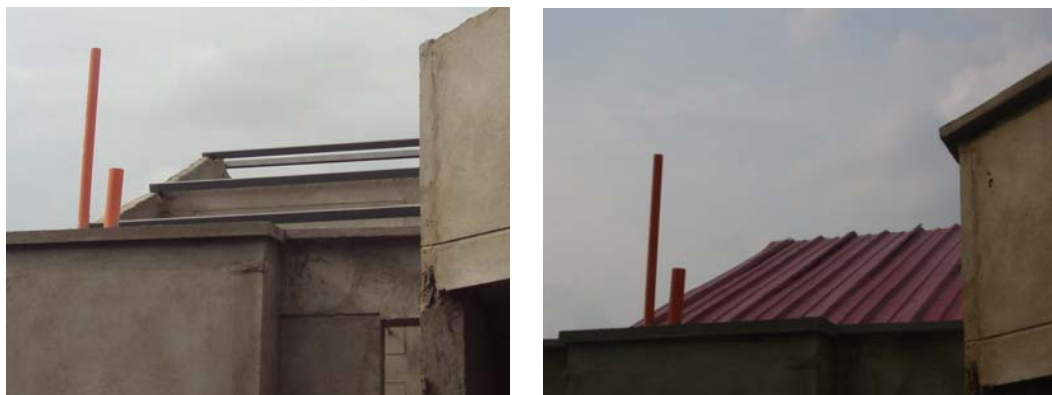
Ilustración 13. Cubierta en teja termo acústica
