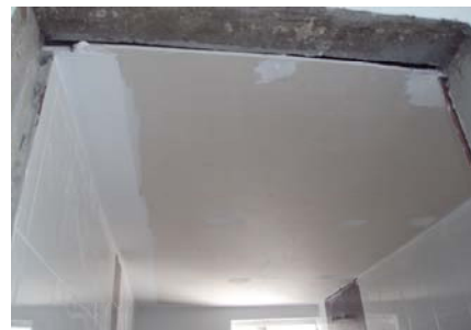
Drywall instalado
