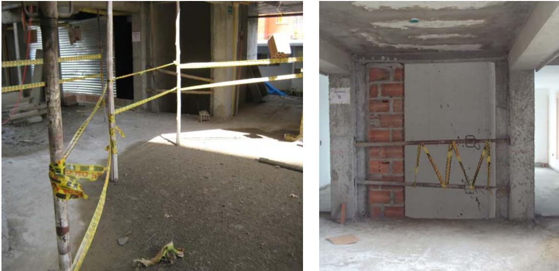
Ilustración 28 Señalización requerida, foso del ascensor
