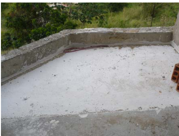
Balcón con producto sika impermeabilizante
