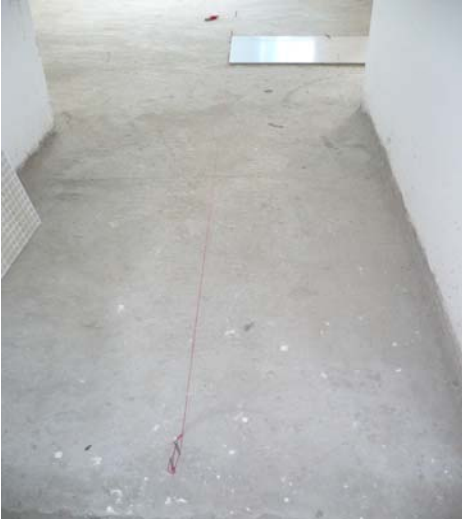
Enchape de piso, primera hilada
