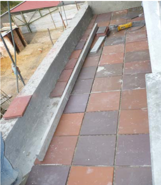
Enchape piso de balcones, Tablón de gres
