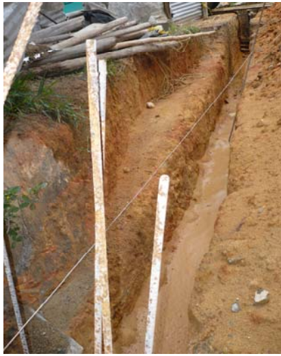
Excavación, viga de cemento
