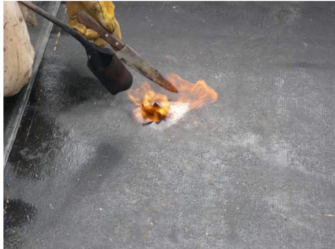
Ilustración 17. Instalación del manto asfáltico
