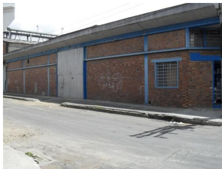
Figura 2. Vista lateral instalaciones de la Empresa
