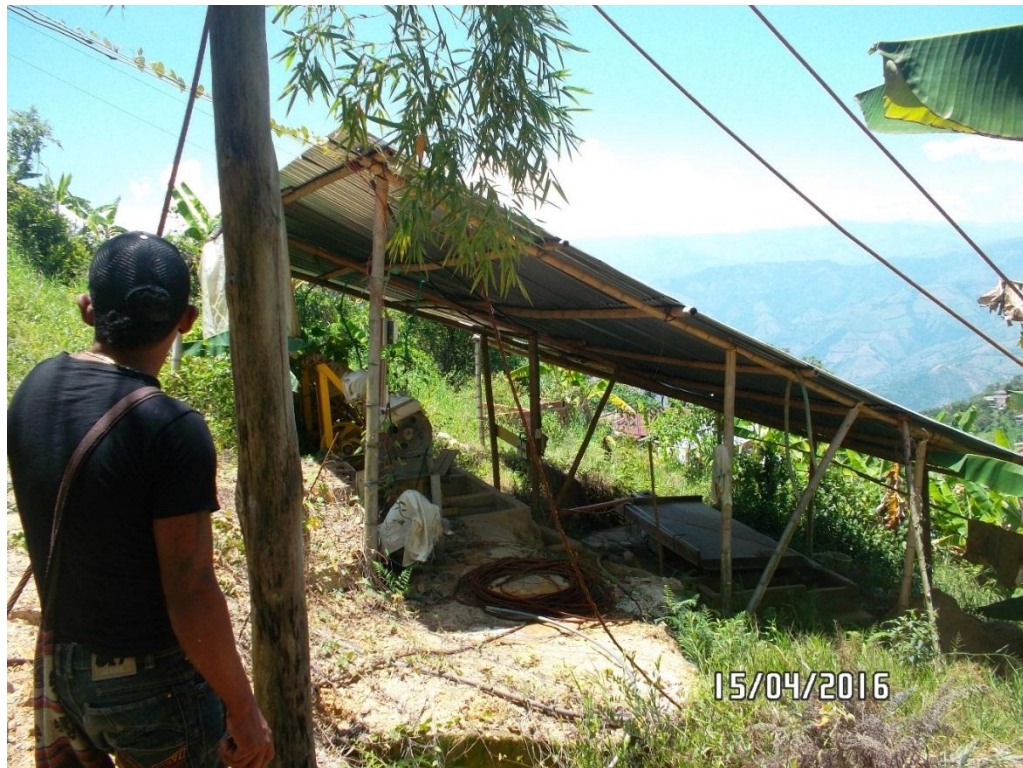
Figura 22. Montaje de beneficio inactivo, vereda zaparrillo
