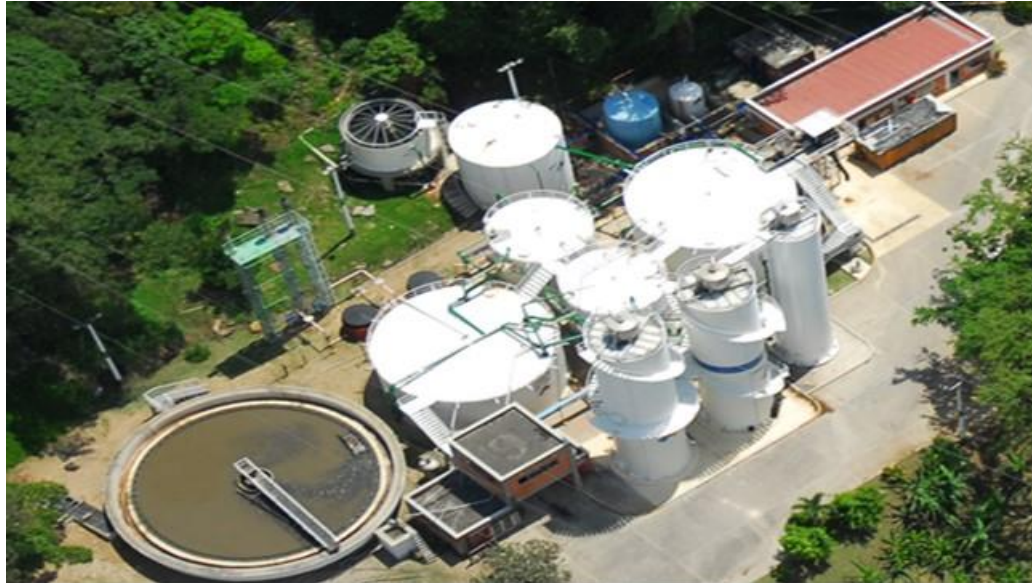
Figura 1. Vista superior de los tanques de almacenamiento de la planta PTAR
