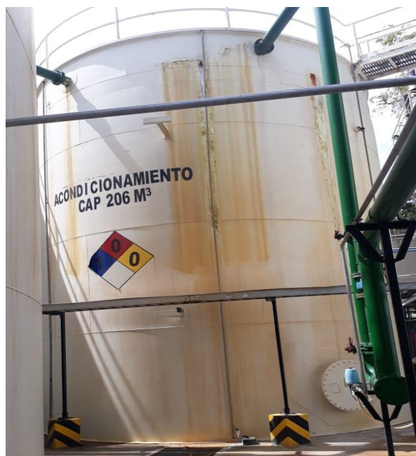
Figura 14. Tanque de Acondicionamiento TA 02
