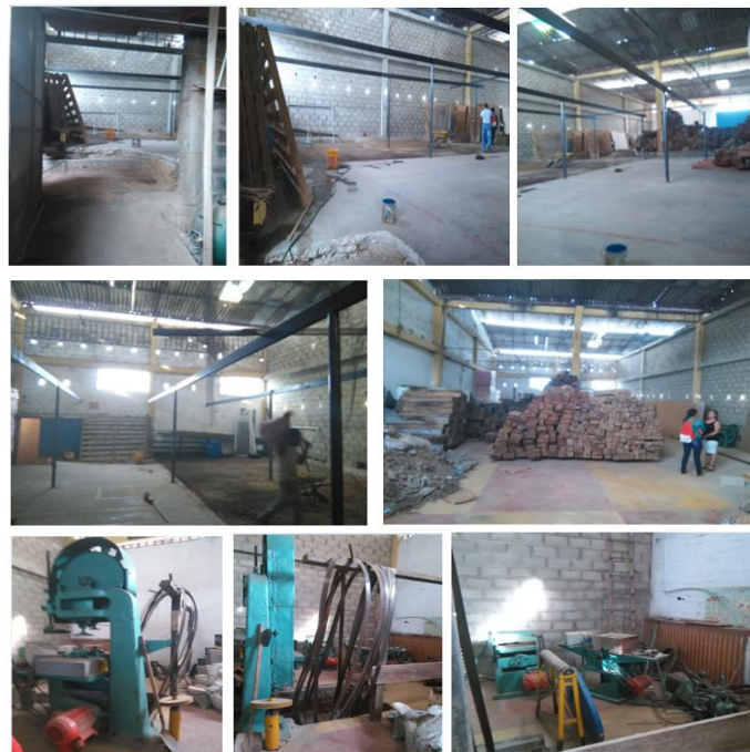
Figura 18. Remodelación y adecuación de nueva Bodega.
