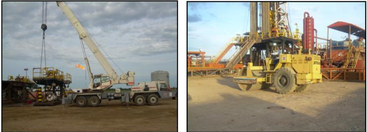
Fotografía 1. Maquinaria utilizada durante la perforación.
