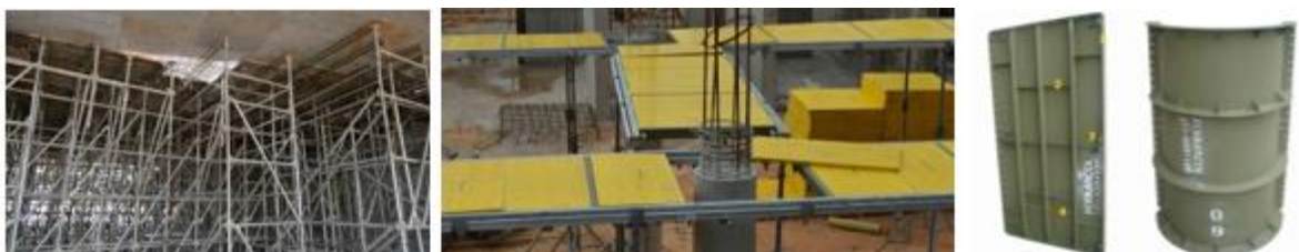
Figura 3. Andamios y encofrados
